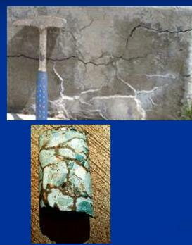
□ Alkalno agregatna reakcija je posljedica reakcije nekih reaktivnih agregata sa cementnim kamenom
