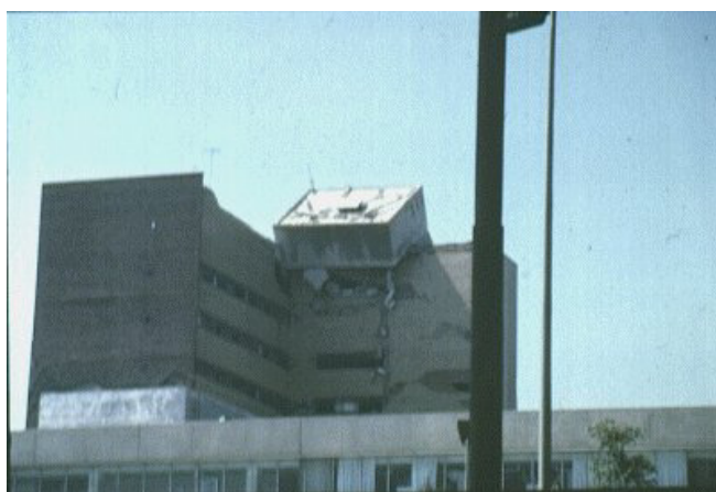
Slika 230.: Primjer oštećenja zgrade u Mexico Cityju s vodospremnikom na vrhu
