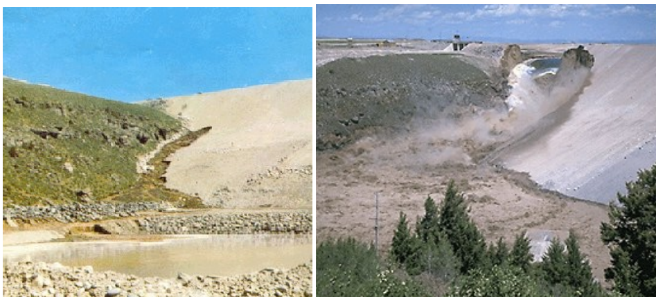
Slika 7-17 Prodor vode iz akumulacije u desnom boku brane Teton, Idaho, SAD 1972. godine: prva pojava vodenog toka (lijevo) i prodor vode u punoj snazi nekoliko trenutaka kasnije (desno)
