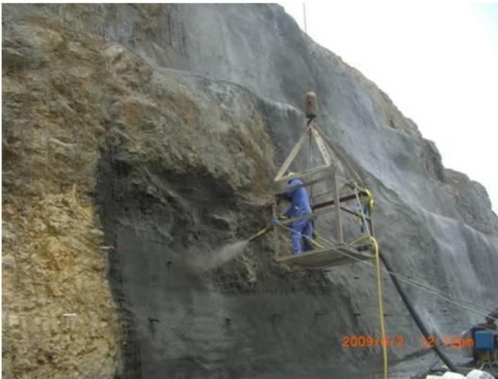
Zaštita stijenskog pokosa mlaznim betonom
