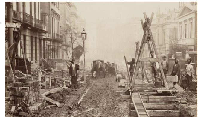
IZVEDBA LONDONSKOG METROA 'CUT AND COVER' METODOM, 1861. godina
