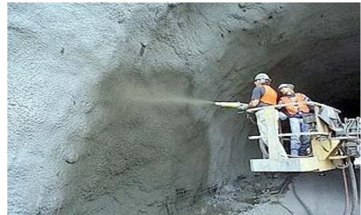
POSTUPAK NANOŠENJA MLAZNOG BETONA
