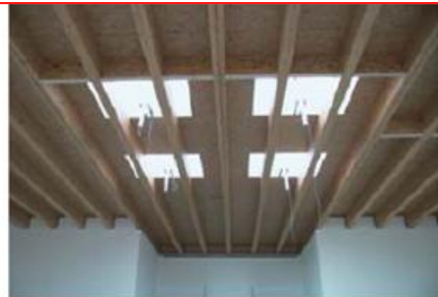
Otvor u stropu za svjetlarnik (stropni prozor)
