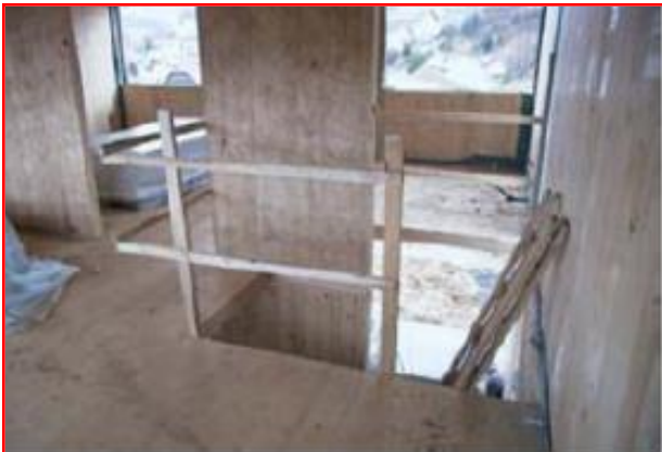
Otvor u stropu za stubište
