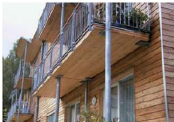
Ploče balkona, točkasto poduprte
