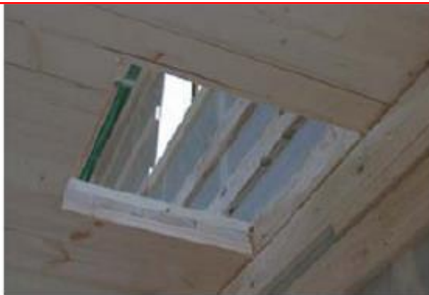
Otvor u stropu za dimnjak
