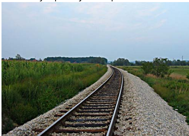
Slika 1. Klasična kolosiječna konstrukcija
