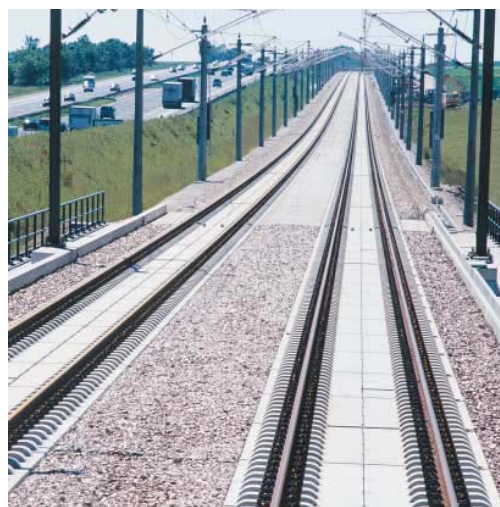
Slika 37. Pojedine faze izvođenja "Bögl" montažnog sustava i konačni izgled kolosijeka, [14]
