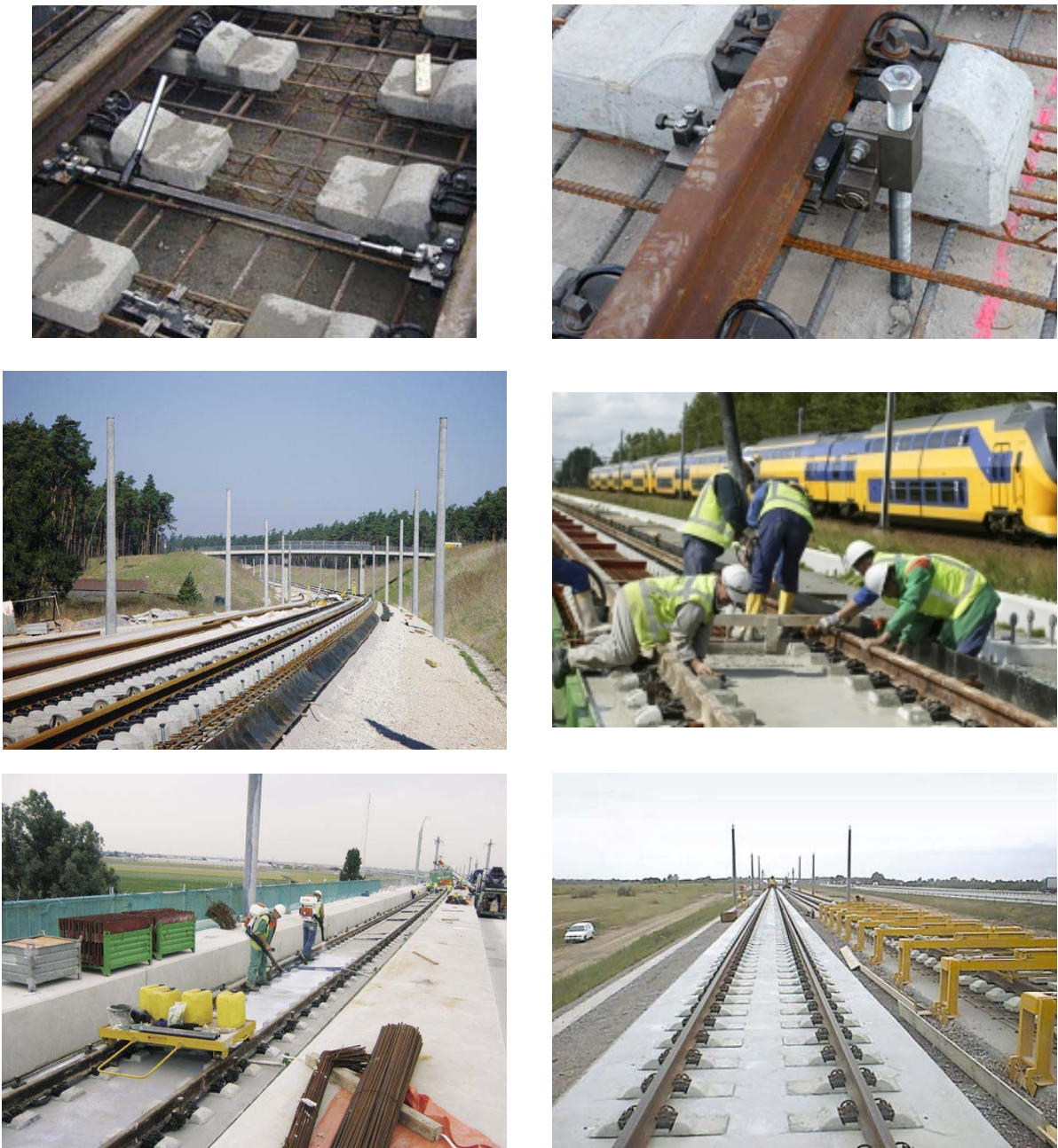
Slika 19. Kronološki prikaza izvođenja kolosiječnog sustava "Rheda 2000"
