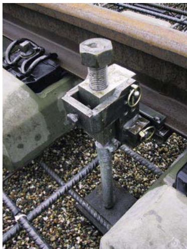
Slika 14. Vijci za vertikalnu regulaciju pragova
