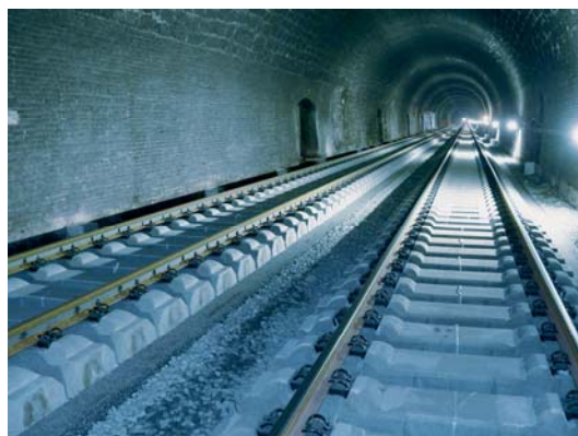
Slika 33. Pojedine faze izvođenja "GETRAC" sustava i konačni izgled kolosijeka
