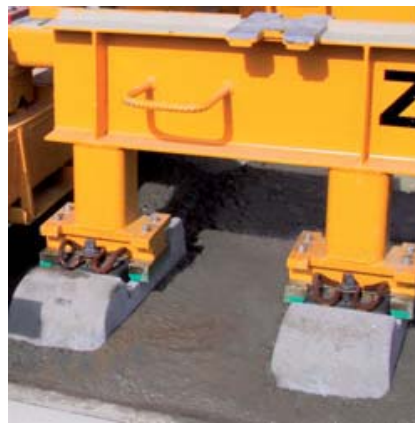
Slika 25. Kronološki prikaza izvođenja "Züblin" kolosječnog sustava, [12]
