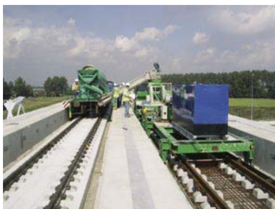
Slika 15. Betoniranje "Rheda" pločastih kolosijeka
