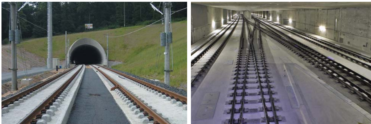
Slika 9. Primjena kolosijeka na čvrstoj podlozi u tunelima, [12, 10]
