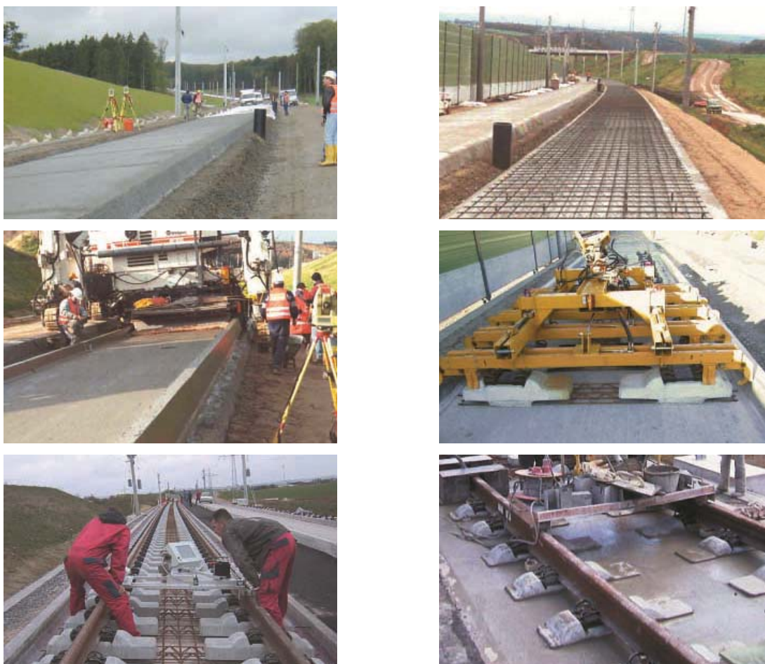
Slika 17. Kronološki prikaz izvođenja sustava "Rheda-Berlin"
