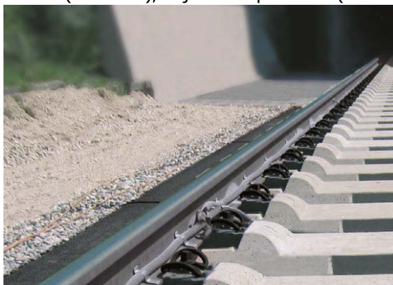
Slika 10. Instalacije uz samu tračnicu, [13]
