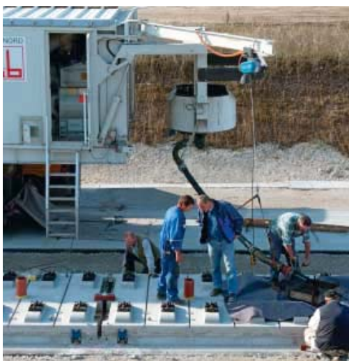
Slika 37. Pojedine faze izvođenja "Bögl" montažnog sustava i konačni izgled kolosijeka, [14]
