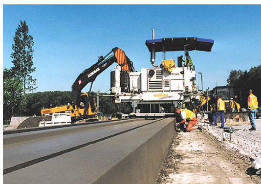
Slika 43. Kolosiječni sustav "EDILON"
