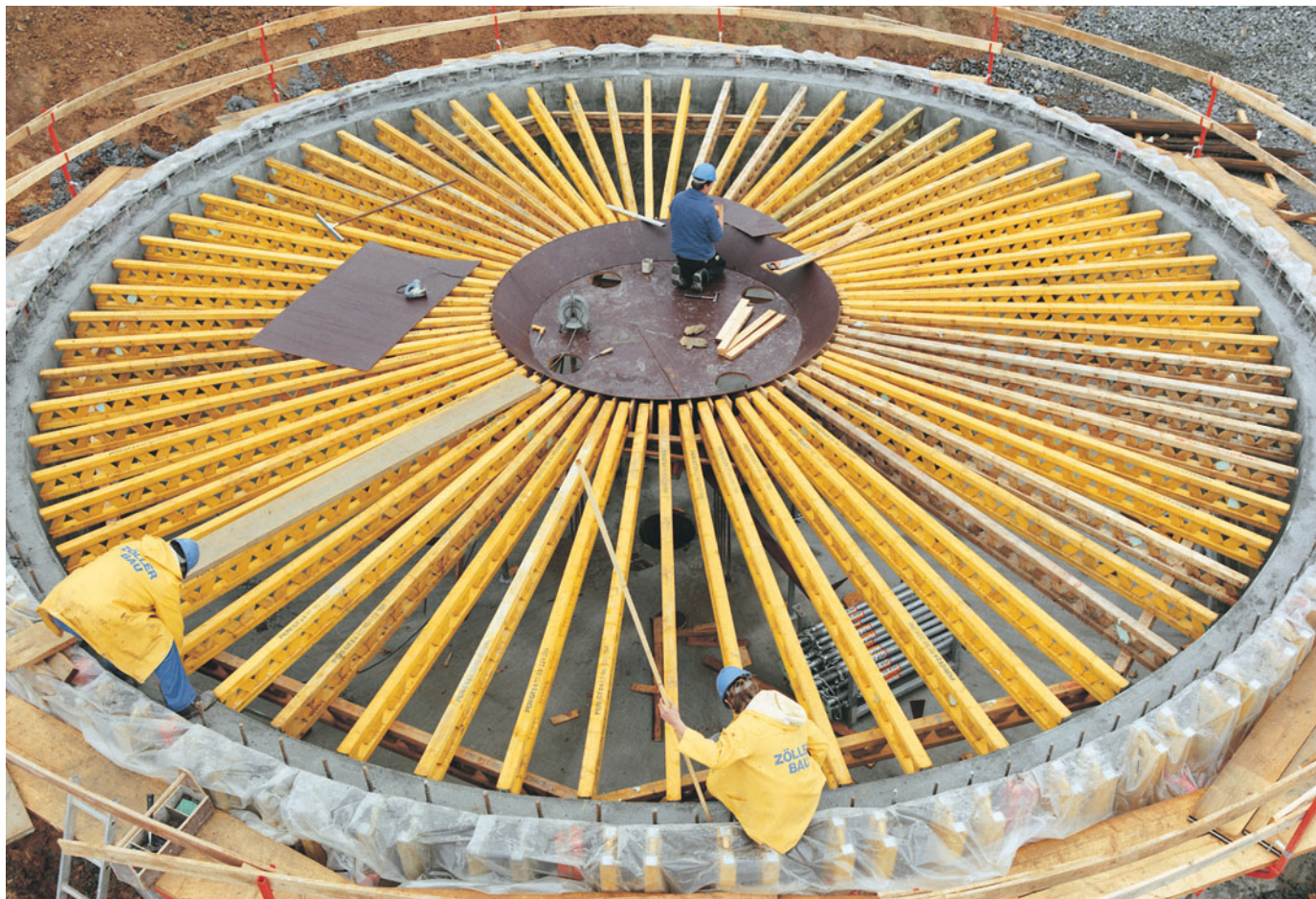
MULTIFLEX s nosačima GT 24 na kružnom rezervoaru promjera 11,60 m te sa stožastim stropom.
