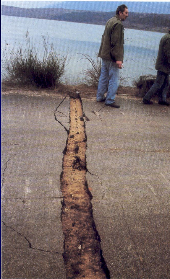
Foto 3. Poprečna pukotina na kruni brani
