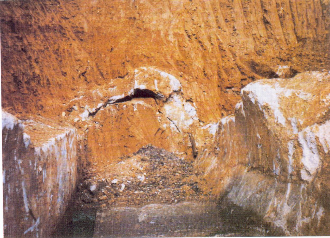
Foto 1. Glinena jezgra na najnižem dijelu iskopa lijevog kraja brane s razrušenom galerijom
