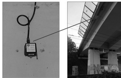
Mjesto postavljanja jednog od senzora akustične emisije za monitoring prednapetog nosača mosta
