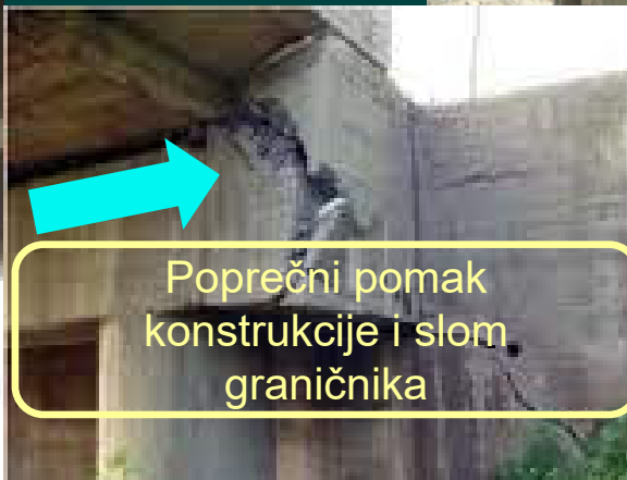
Poprečni pomak konstrukcije i ispadanje s ležajne klupe
