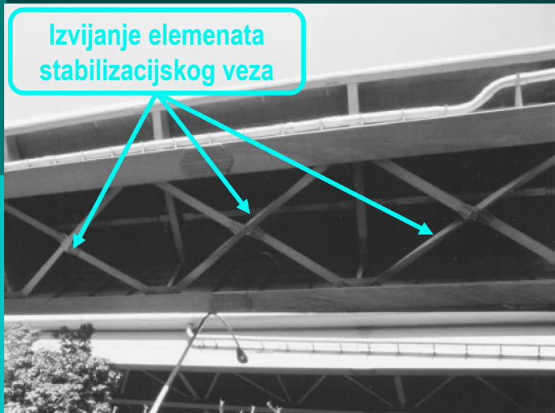
Udar rasponskog sklopa u rasponski sklop
