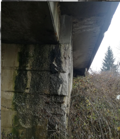
Udar rasponskog sklopa u rasponski sklop
