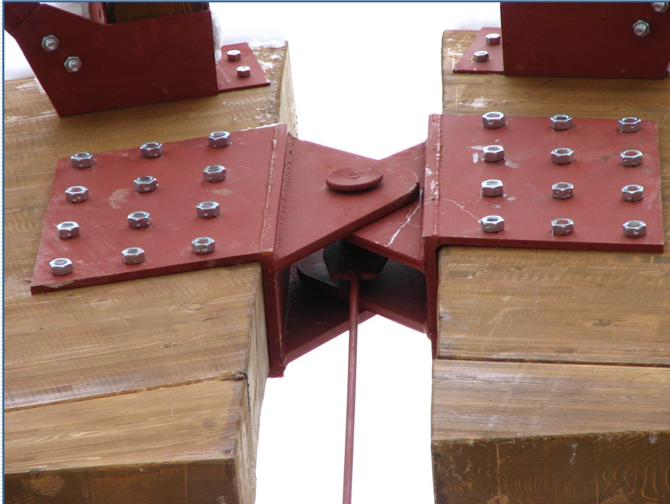
Varijanta “bolzen” zgloba
