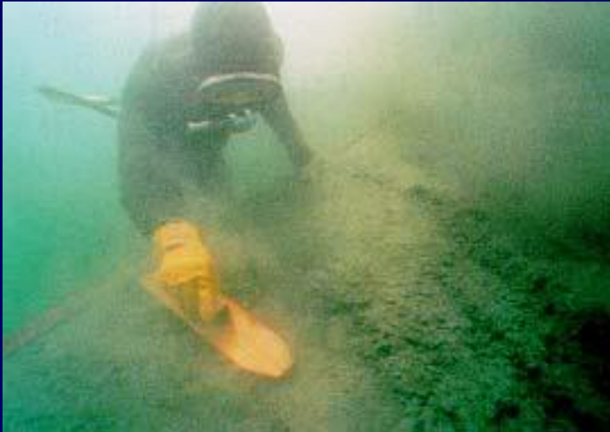
Završna obrada podvodnog betona
