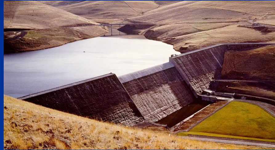
Prva brana od valjanog betona-Willow Creek (SAD), u manje od pet mjeseci ugrađeno je više od 315 000 m 3 valjanog betona, visina brane je 52 metra
