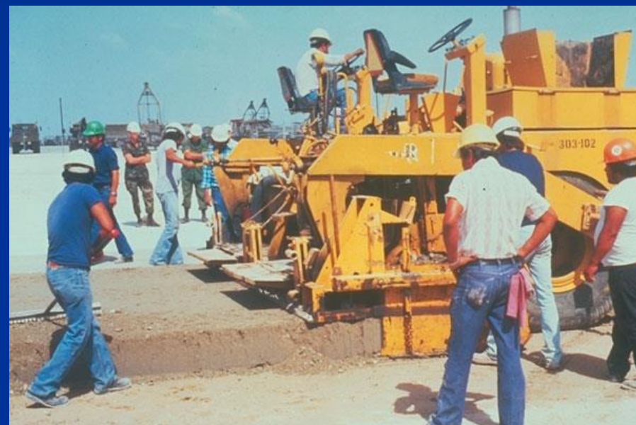
Ugradnja valjanog betona s modificiranim uređajem za ugradnju asfalta
