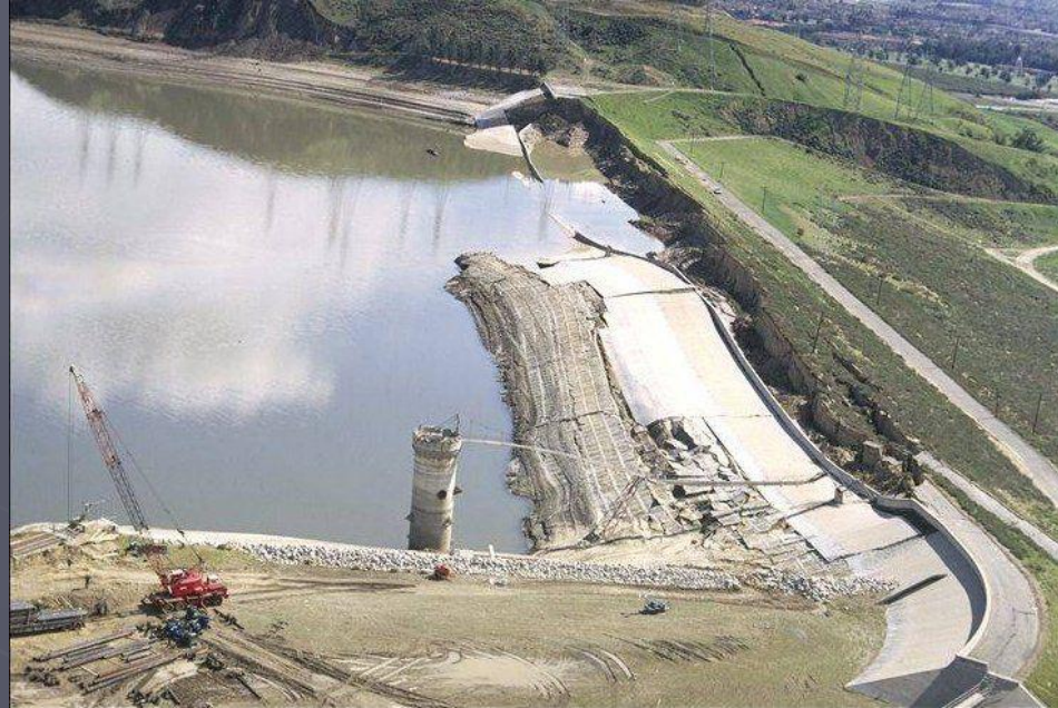
Brana San Fernando , nakon potresa 1972
