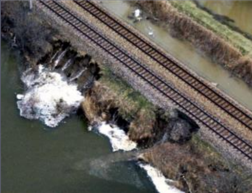
Procjeđivanje kroz tijelo željezničkog nasipa (piping)
