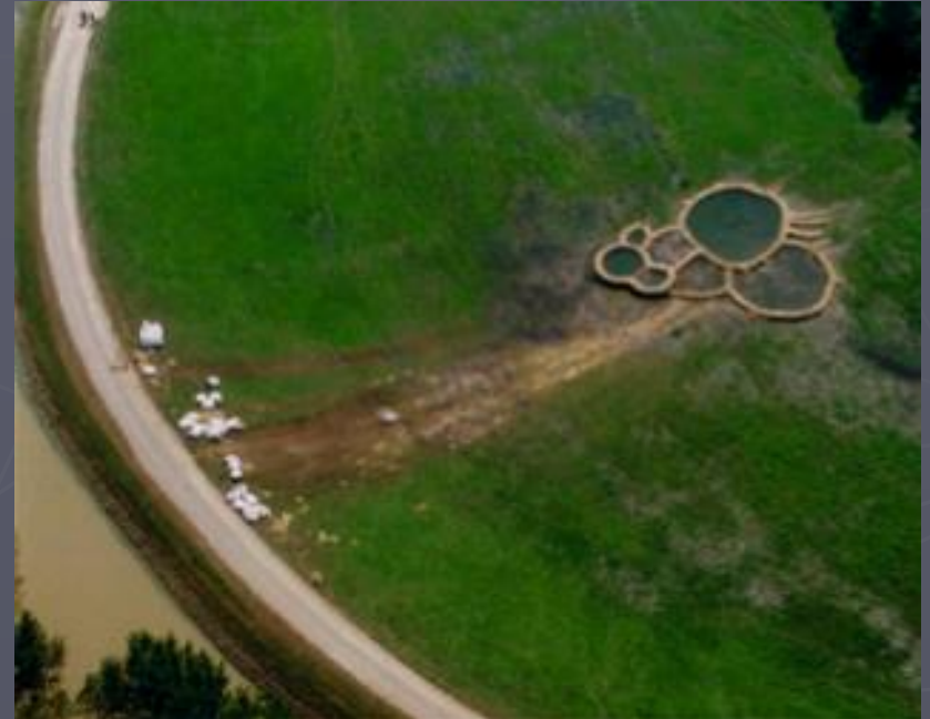
Procjeđivanje daleko izvan tijela nasipa i mjere za stabilizaciju - podizanje 'zidova' i izrada 'bunara'
