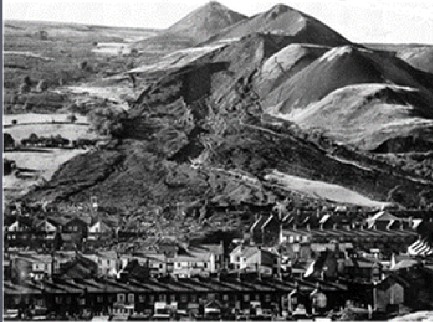
Slika 3-6 Veliko klizište na nasipu rudarske jalovine u Aberfanu (Velika Britanija) 1966. godine koje je usmrtilo nekoliko desetaka ljudi
