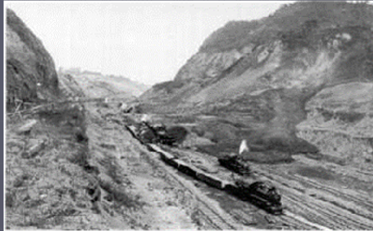
Slika 3-1 Panamski kanal: klizanje 13 milijuna kubičnih metara tla pri iskopu bokova kanala (1913. godina)
