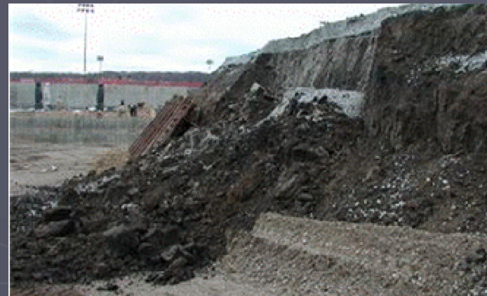
Slika 3-4 Klizanja tla na kosinama usjeka
