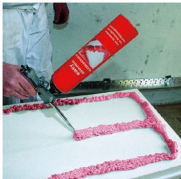
Slika 2-4 Jednokomponentno PUR ljepilo za lijepljenje EPS-a [49]
