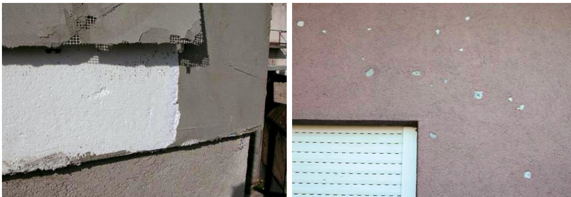
Slika 2-94 Pretanak armaturni sloj [49]
