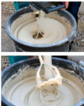
Slika 2-3 Priprema polimer-cementnog ljepila [49]
