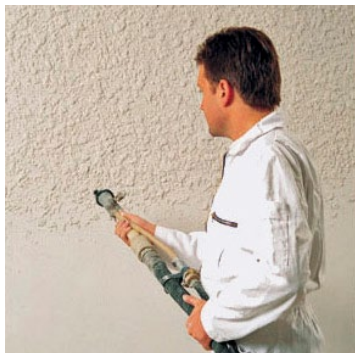
Slika 2-10 Nanošenje završno dekorativne žbuke [78], [49]
