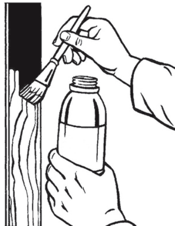
Slika 2-136 Nanošenje predpremaza na drvenu podkonstrukciju [140]
