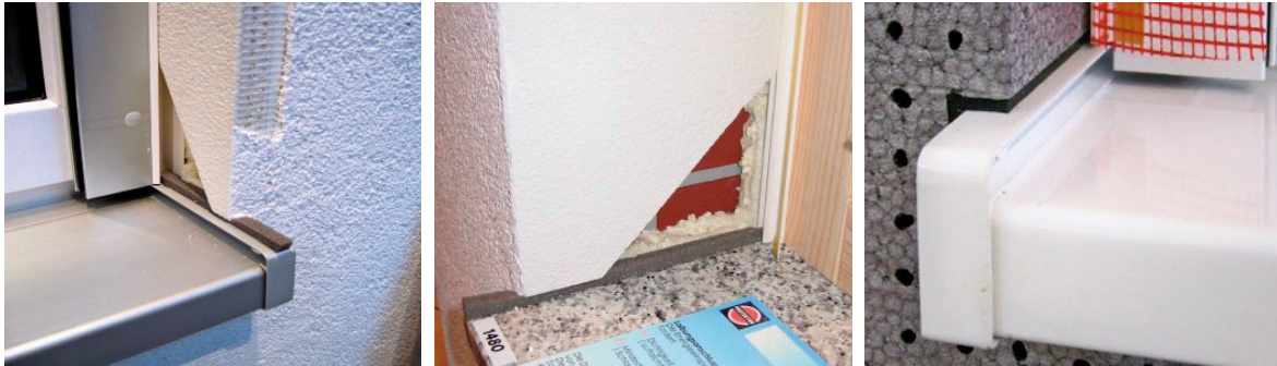
Slika 2-66 Izgled spoja ETICS sustava i prozorske klupčice [49]
