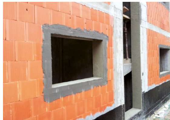
Slika 2-176 Žbukanje zidarskih otvora [173]
