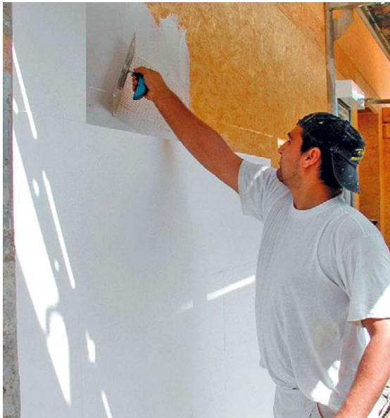
Slika 2-11 Izvedba ETICS sustava na OSB ploče [49]
