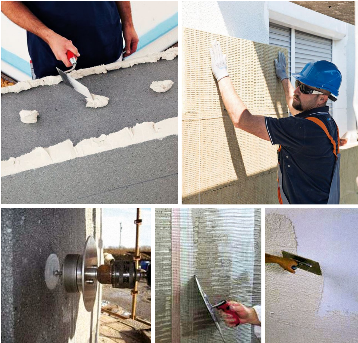
Slika 2-2 Osnovne faze izvođenja ETICS sustava [49]
