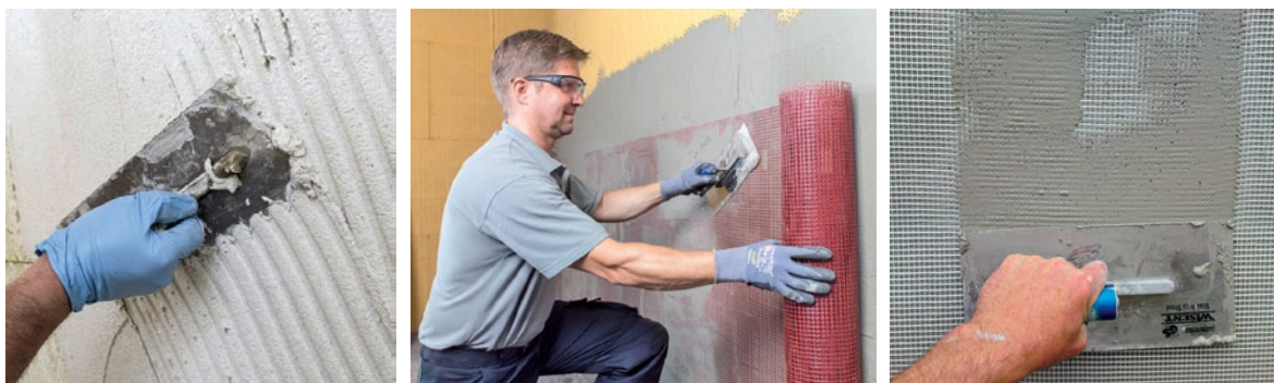
Slika 2-8 Nanošenje temeljnog polimer-cementnog sloja na mineralnu vunu (lijevo), utiskivanje staklene mrežice (desno) [49]
