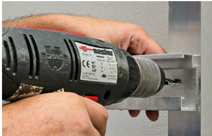
Slika 2-128 Izvođenje aluminijske podkonstrukcije ventilirane fasade [148]
