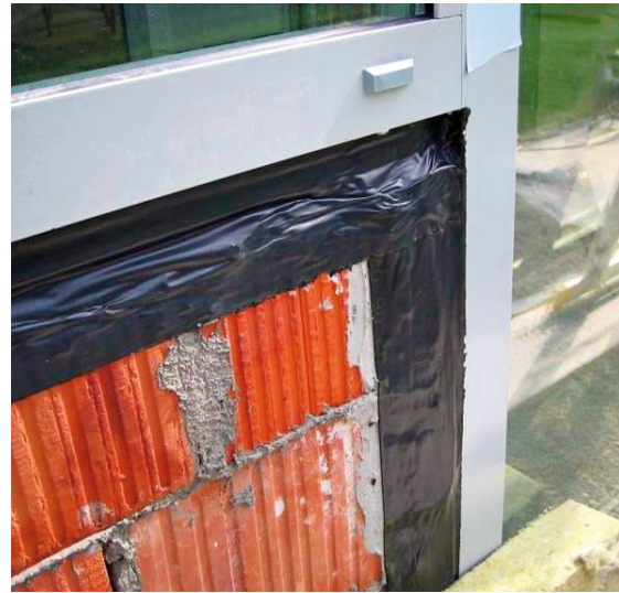
Slika 2-175 Primjer brtvljenja folijom [174]
