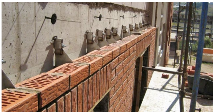
Slika 1-91 Primjer ugradnje konzola [70]
