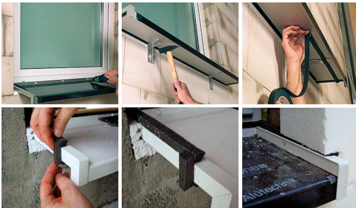
Slika 2-65 Ugradnja i brtvljenje prozorske klupčice [99], [49]
