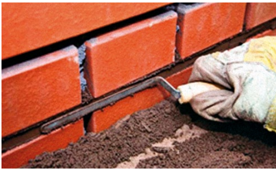
Slika 1-80 Naknadno izvođenje reške [69]
