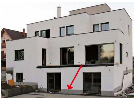
Slika 2-19 Podnožje u ravnini s pročeljem i odvojenim / različitim završnim slojem [49]
