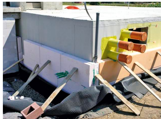
Slika 2-14 Toplinska izolacija zida prema tlu [49]
