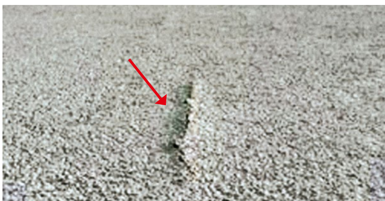
Slika 2-103 Kod nestručnog spajanja atike oborinska voda može prodrijeti u ETICS sustav zbog djelovanja tlaka vjetra na nju i pritom prouzročiti oštećenja [110]
