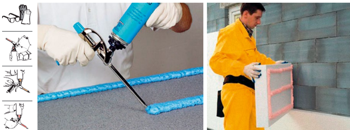
Slika 2-28 PUR ljepilo za EPS ploče [84], [85]
