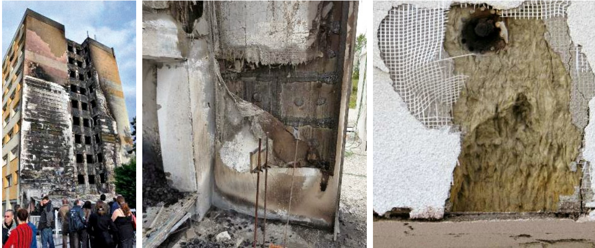
Slika 2-109 Oštećenje uslijed požara, izgled ETICS sustava nakon realnog požara EPSa i mineralne vune (ispitivanje prema BS 8414) [133], [49], [134], [110]
