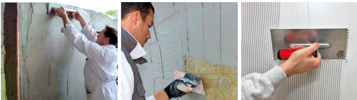
Slika 2-48 Nanošenje morta za armaturni sloj [49], [87]
