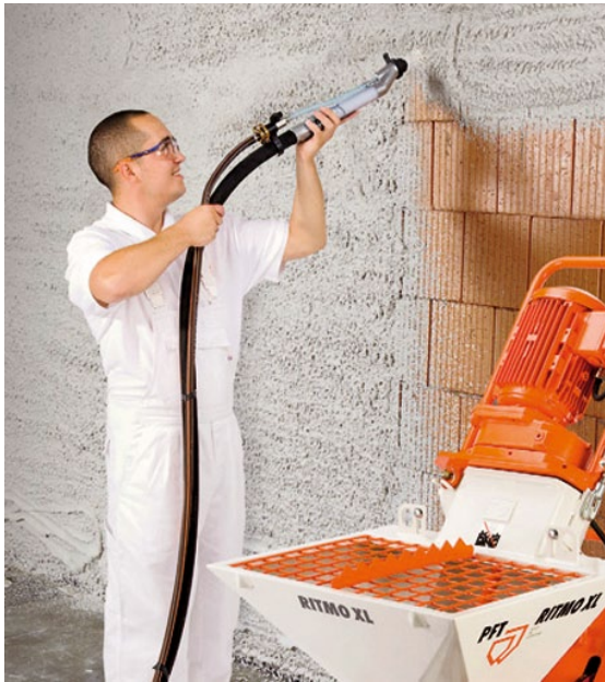
Slika 1-95 Ugradnja jednoslojne žbuke [72]
