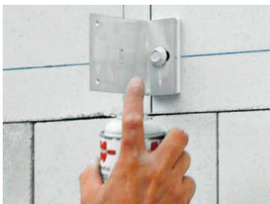
Slika 2-145 Ugradnja aluminijskog nosača podkonstrukcije [49]
