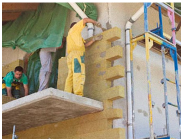
Slika 2-31 Postavljanje toplinsko-izolacijske ploče i lamele na uglovima objekta [49]
