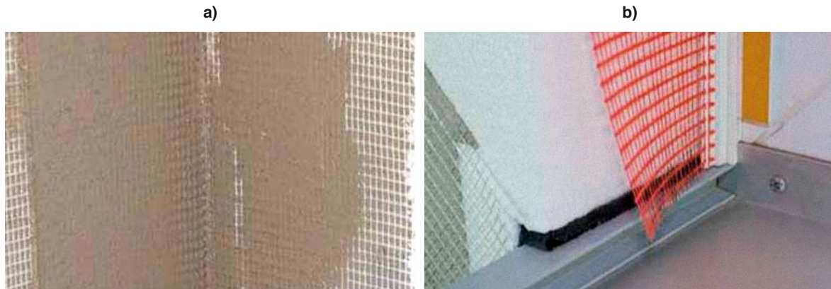
Slika 2-60 Armiranje a) kutova; b) spoja s doprozornikom [49]
