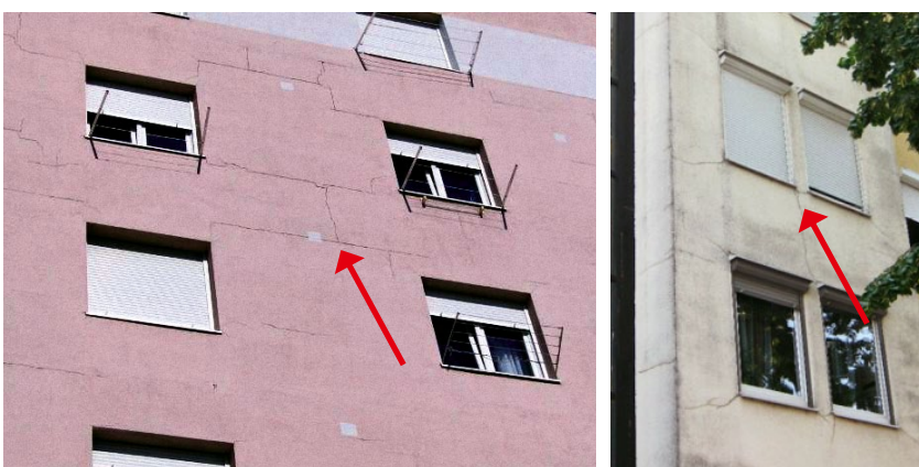
Slika 2-93 Neodgovarajuće ugrađen ETICS sustav
