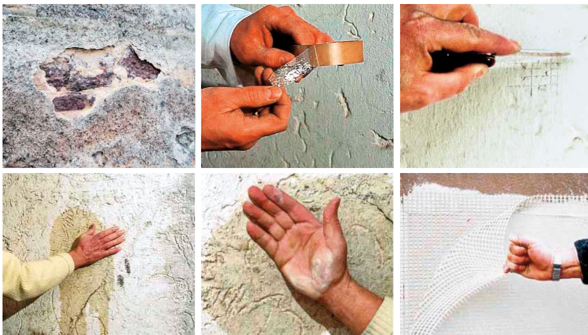
Slika 2-12 Načini ispitivanja postojeće žbuke prije izvođenja novog ETICS sustava [49]
