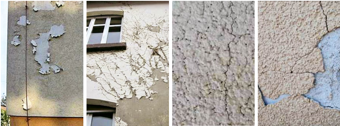
Slika 2-99 Djelomično oljuštena završna žbuka ETICS sustava, porozna struktura žbuke [120], [110]
