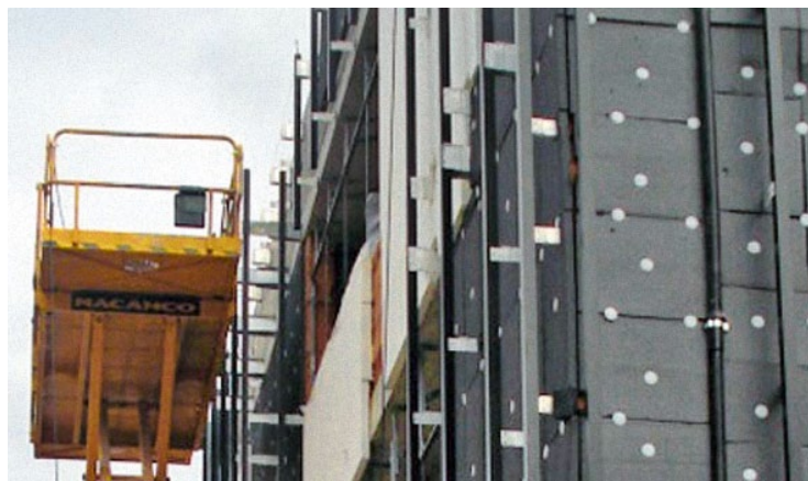
Slika 2-128 Izvođenje aluminijske podkonstrukcije ventilirane fasade [148]
