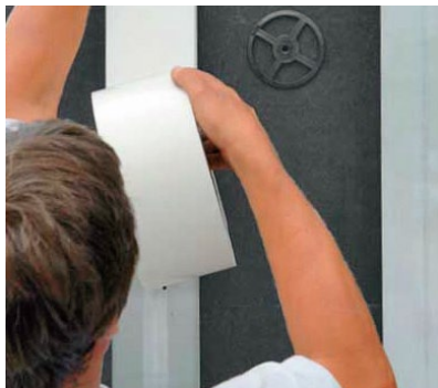
Slika 2-148 Ugradnja okomitih štapova aluminijske podkonstrukcije [49]
