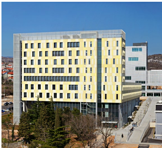
Slika 2-161 Ventilirana fasada, Sveučilišni kampus na Trsatu, Rijeka, studeni 2011. [162]
