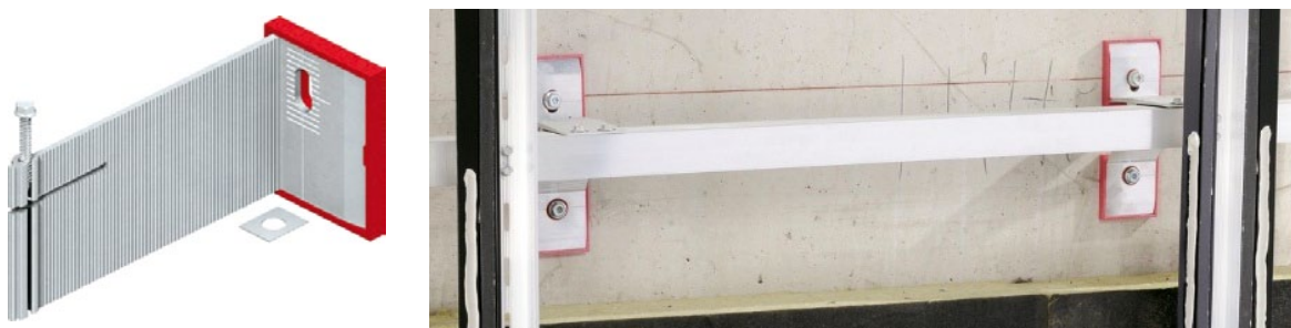
Slika 2-153 Moguća izvedba prekida toplinskog mosta [155], [156]
