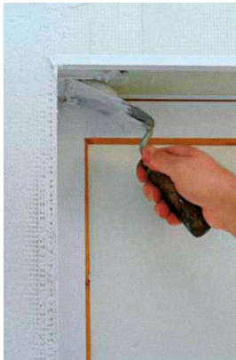
Slika 2-151 Izvedba završne žbuke [49]
