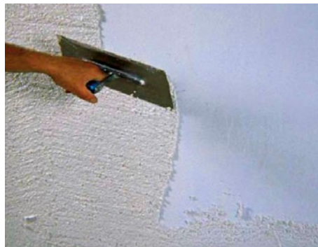
Slika 2-10 Nanošenje završno dekorativne žbuke [78], [49]
