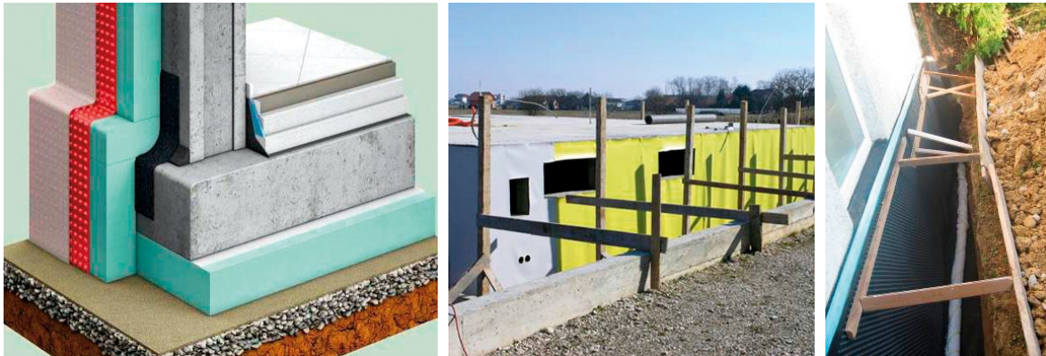
Slika 2-22 Hidroizolacija podruma, toplinska izolacija XPS-om i zaštita toplinske izolacije čepastom folijom [81], [49], [82]
