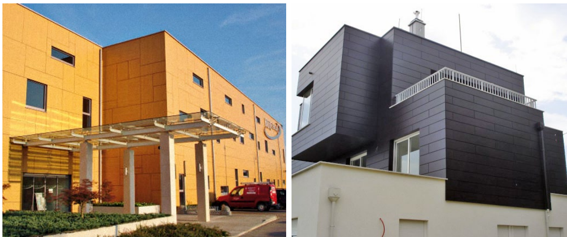
Slika 2-116 Izgled ventilirane fasade s HPL pločama [144], [145]
