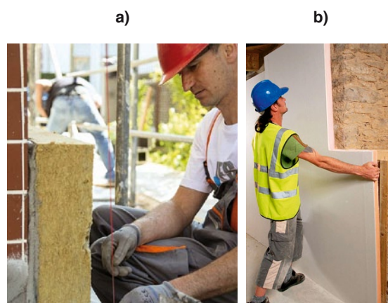
Slika 1-53 Položaj toplinske izolacije u zgradi, a) s vanjske strane, b) s unutarnje strane
