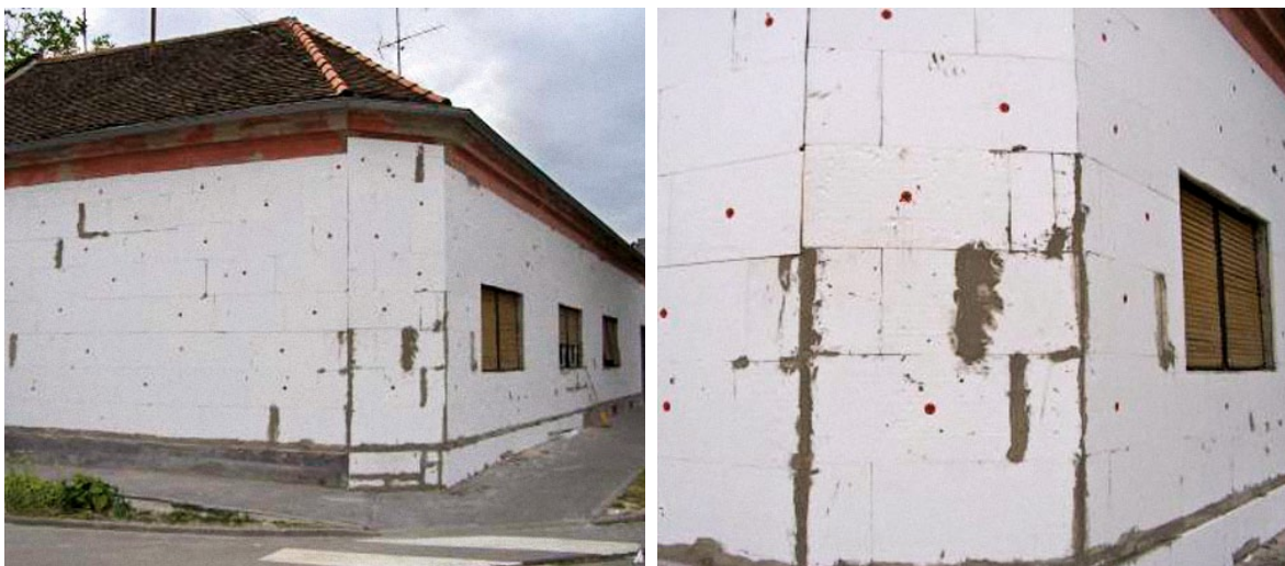
Slika 2-88 Neodgovarajuće ugrađen ETICS sustav [49]
