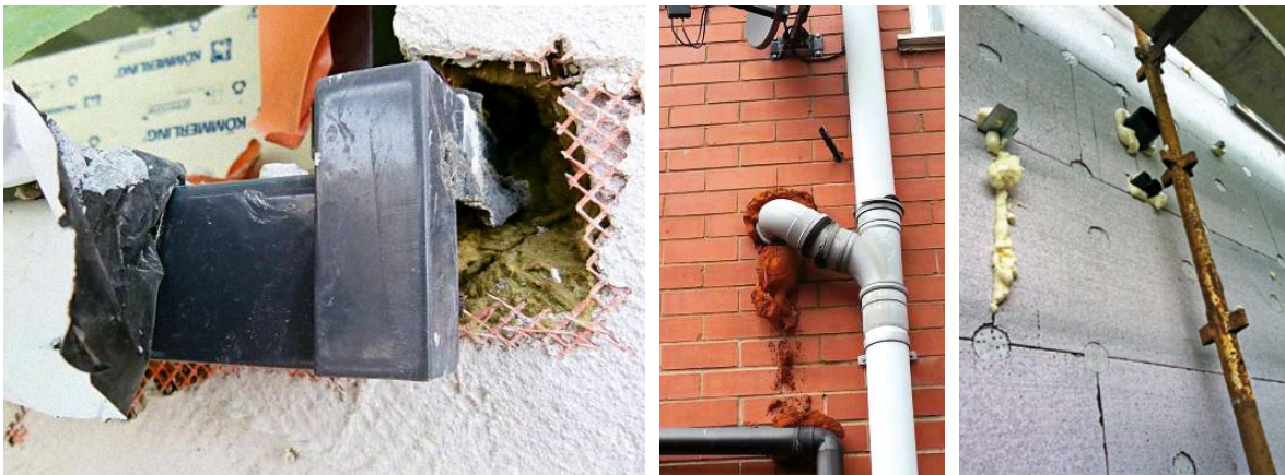
Slika 2-100 Loše izvedeni i nezabrtvljeni prodori ETICS sustava [120], [126], [127]
