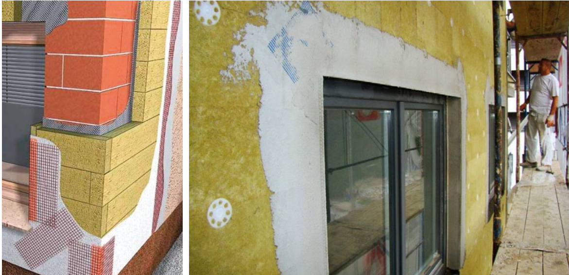
Slika 2-56 Izvedba ruba i kuta pomoću kutnog profila [49], [95]
