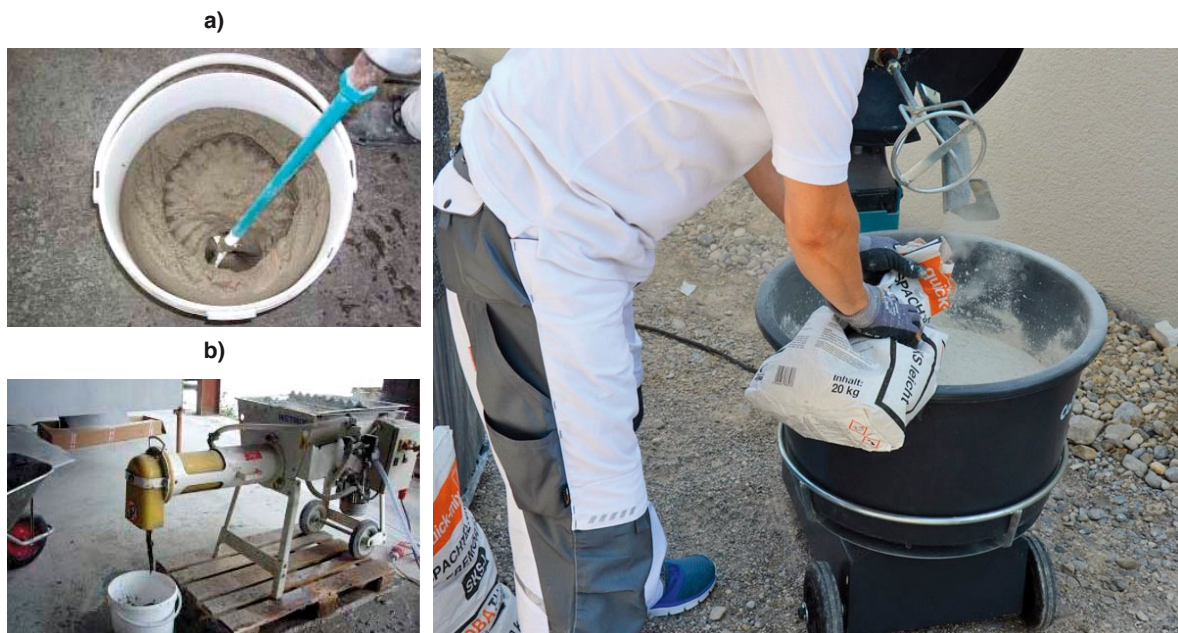
Slika 2-50 Miješanje morta za armaturni sloj: a) električna miješalica; b) horizontalna miješalica [49]
