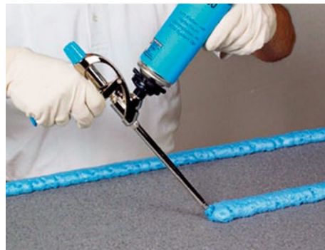
Slika 2-4 Jednokomponentno PUR ljepilo za lijepljenje EPS-a [49]
