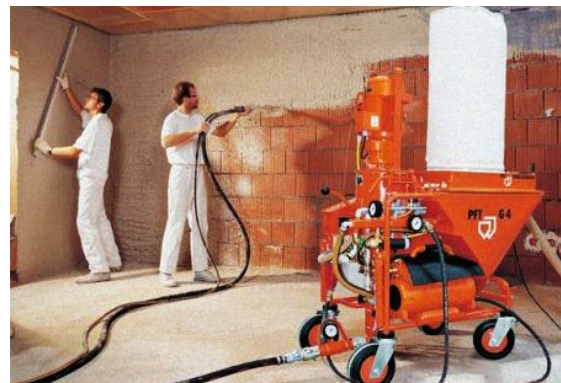
Slika 1-94 Nanošenje žbuke za strojno žbukanje direktno na podlogu [71]
