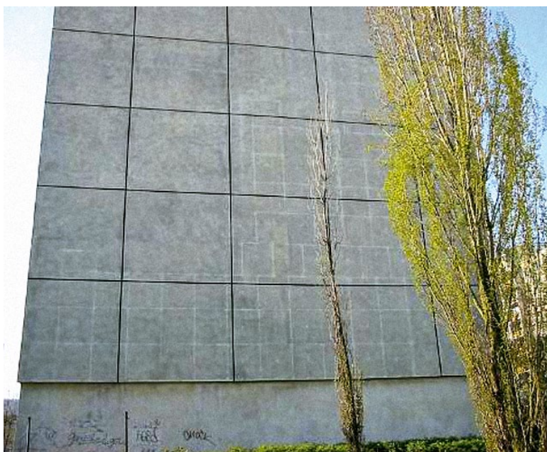
Slika 2-104 Posljedica difuzije vodene pare zbog loše ugradnje ploča EPS-a u ETICS sustav [130]
