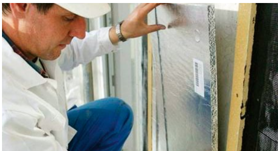
Slika 1-61 Vakumski izolacijski paneli [55]
