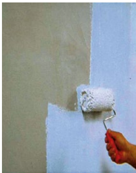
Slika 2-9 Nanošenje predpremaza [49]
