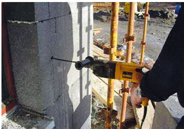
Slika 2-36 Bušenje rupa za pričvrsnice [49]
