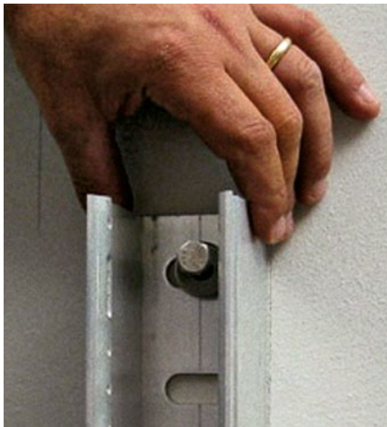
Slika 2-128 Izvođenje aluminijske podkonstrukcije ventilirane fasade [148]
