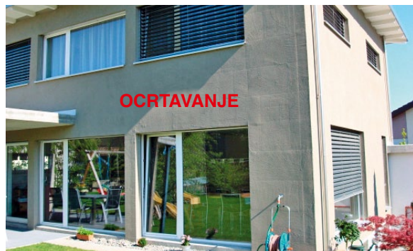
Slika 2-23 Deformacije kod toplinsko-izolacijskih materijala, shematski i primjer lošeg izvođenja [49], [83]
