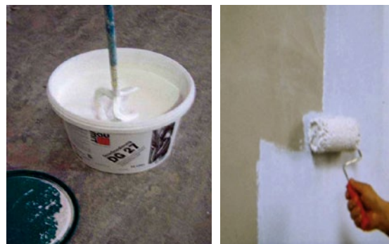
Slika 2-74 Miješanje i nanošenje predpremaza
