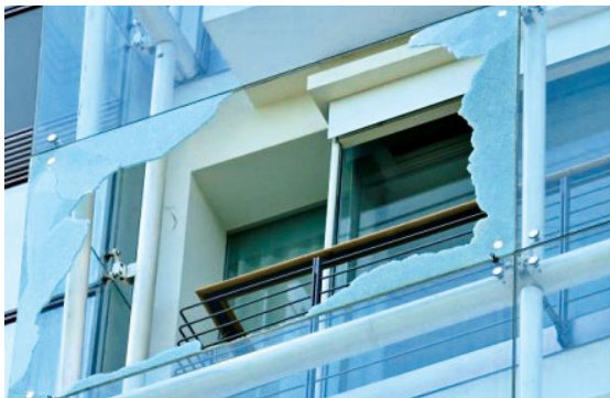
Slika 2-168 Primjer pucanja stakla vanjske ovojnice [168]
