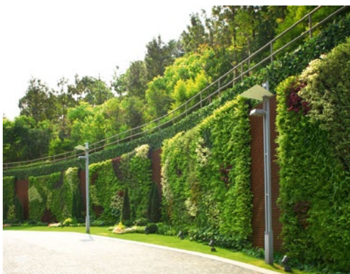
Slika 2-186 Vanjska primjena zelene fasade [183]
