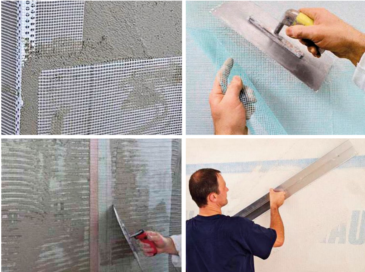
Slika 2-49 Umetanje staklene mrežice u prvi sloj morta [88], [89] [49]
