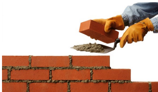
Slika 1-74 Prikaz zidanja opekom NF i mortom [67]
