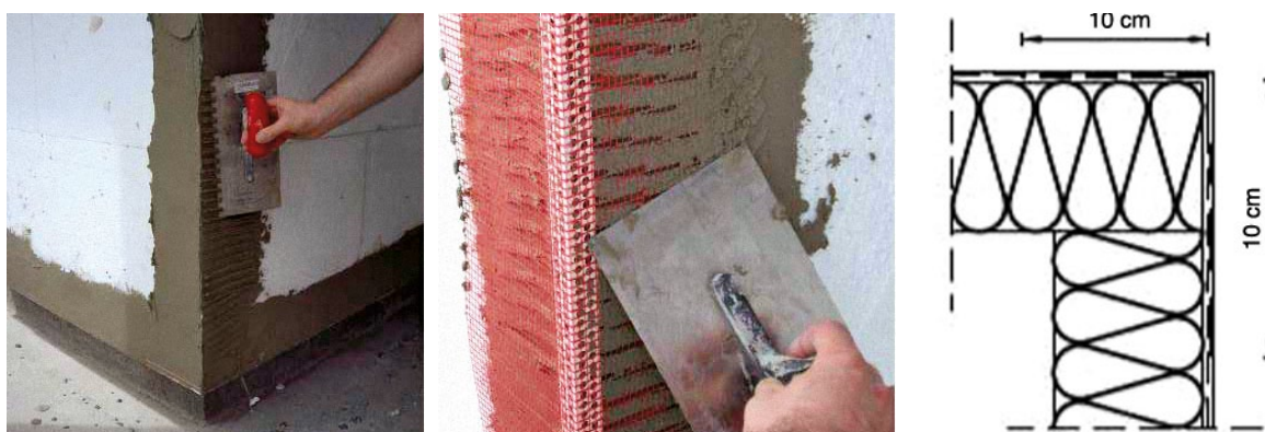
Slika 2-55 Izvedba ruba i kuta pomoću kutnog profila
