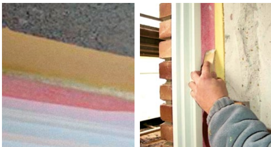
Slika 2-173 Primjer pričvršćenja unutarnjih paronepropusnih traka na građevinski element [173]
