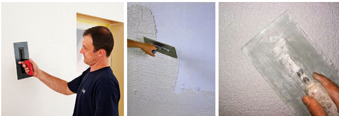
Slika 2-76 Nanošenje završno-dekorativne žbuke [49]
