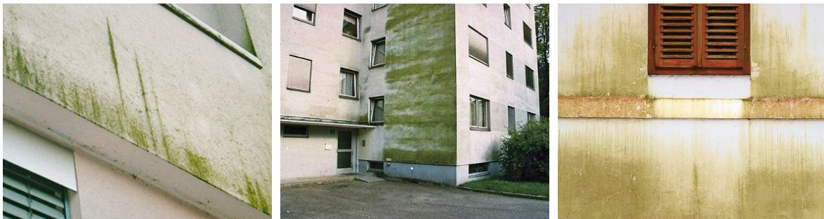
Slika 2-106 Pojava algi na završnom sloju ETICS sustava s vremenom, pogotovo na rubu gdje nema okapnice; dolazi do odvajanja žbuke zbog kiše koja stalno kaplje.
