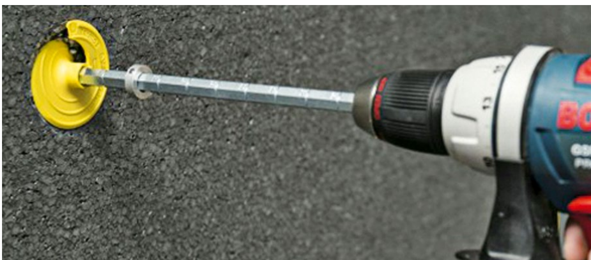
Slika 2-5 Dodatno mehaničko pričvršćivanje toplinske izolacije [49]
