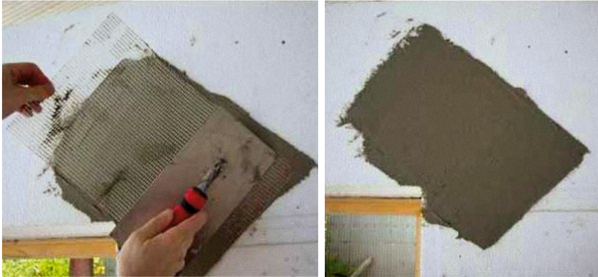
Slika 2-51 Dijagonalno armiranje uglova prozora
