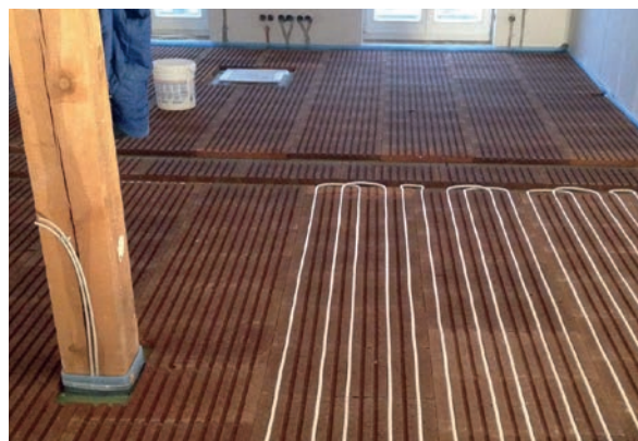
Slika 2-136 Primjeri postavljanja elemenata za podno grijanje [91], [181], [182], [38]
