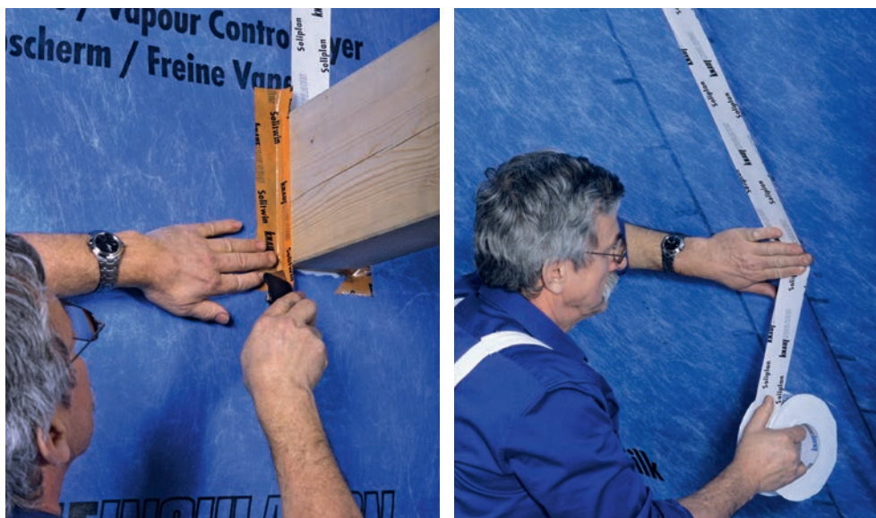
Slika 2-29 Lijepljenje parne brane [1]
