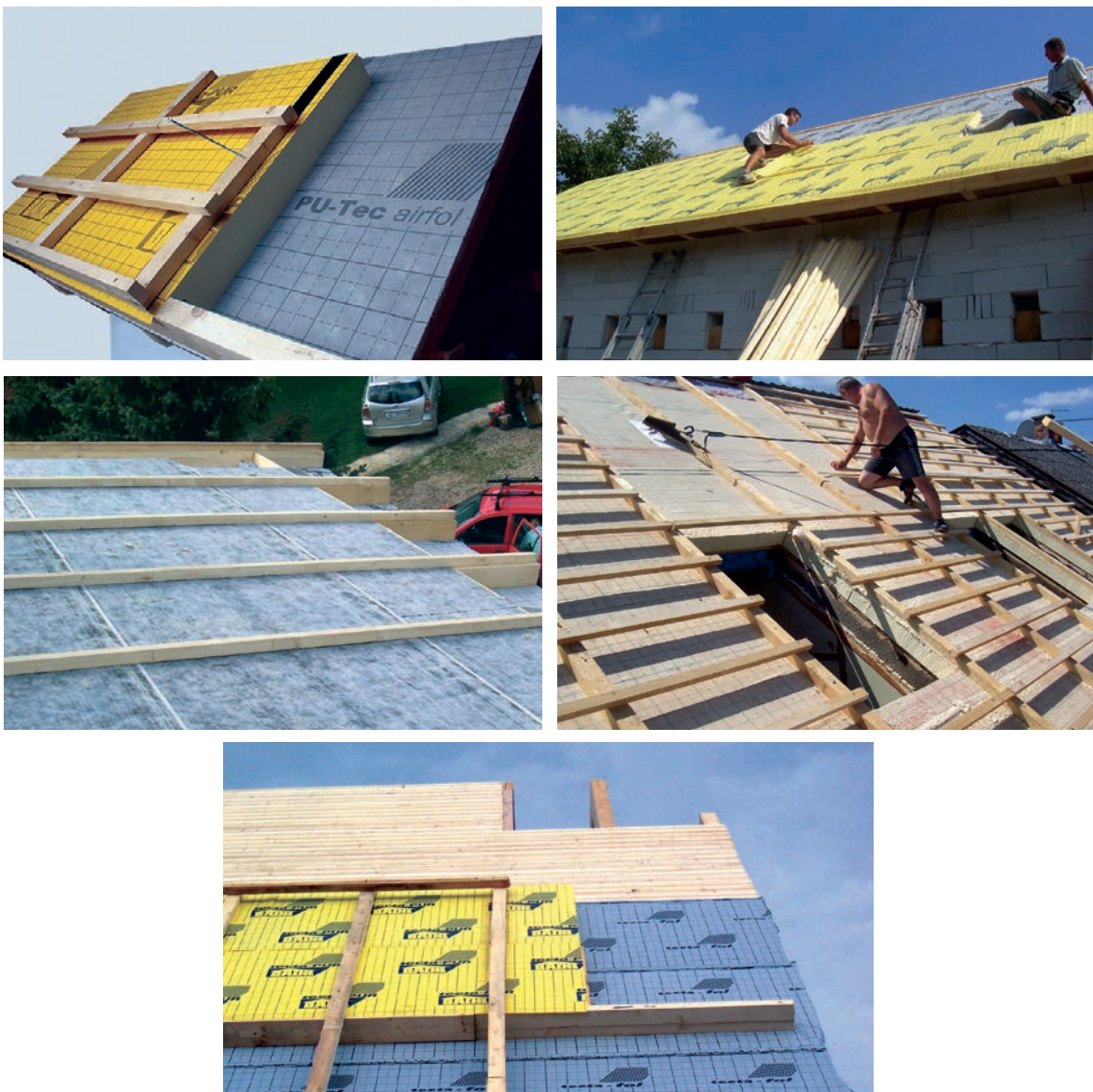
Slika 2-113 Postavljanje toplinske izolacije od tvrdih ploča toplinske izolacije od PUR-a ili PIR-a iznad rogova [148]
