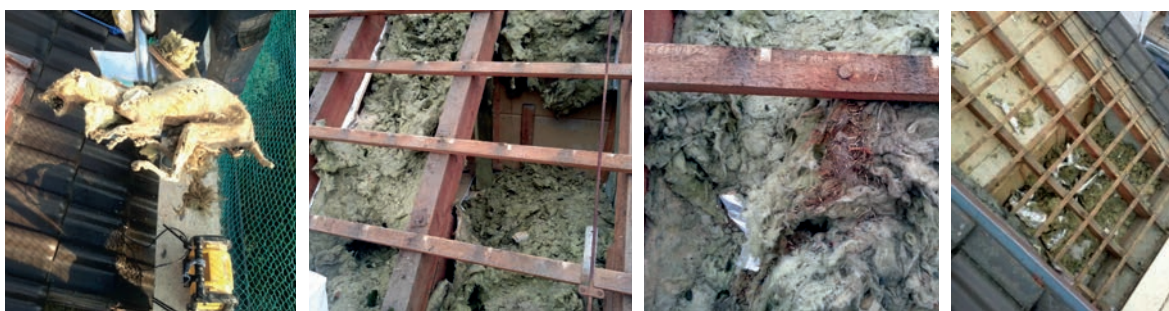
Slika 2-97 Oštećenje toplinske izolacije zbog glodavaca [138]
