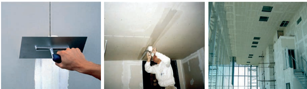
Slika 2-146 Završna obrada površine gipsanih ploča [82]
