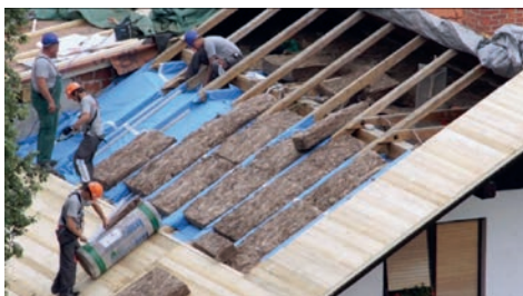
5) Postavljanje mekane mineralne vune između rogova
