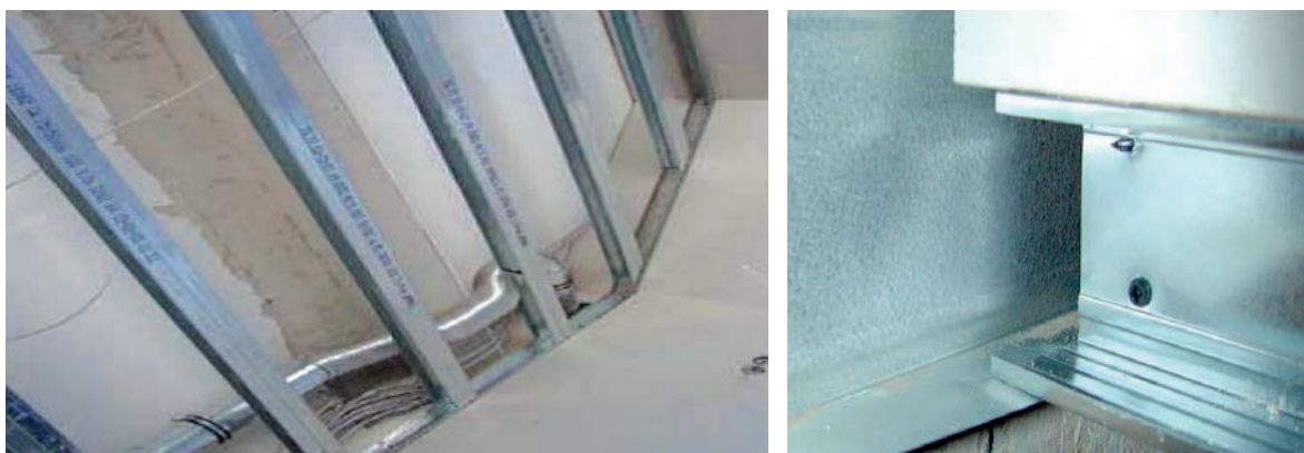
Slika 2-78 Samonosivi spuštteni strop [38]
