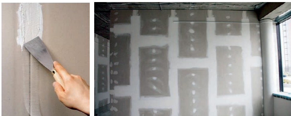
Slika 2-148 Primjena bandažne trake i ispunjivača spojeva [208], [1]
