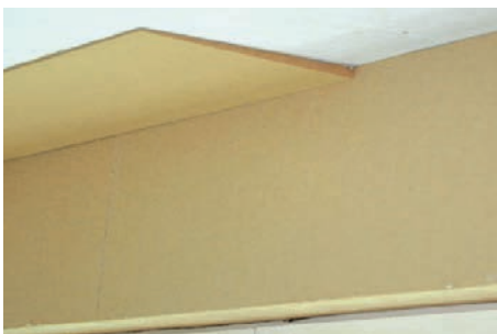
Slika 2-37 Prikaz klina toplinske izolacije susjednih građevnih dijelova [104]
