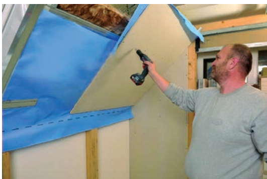
Slika 2-100 Postupak postavljanja toplinske između i ispod rogova [139]
