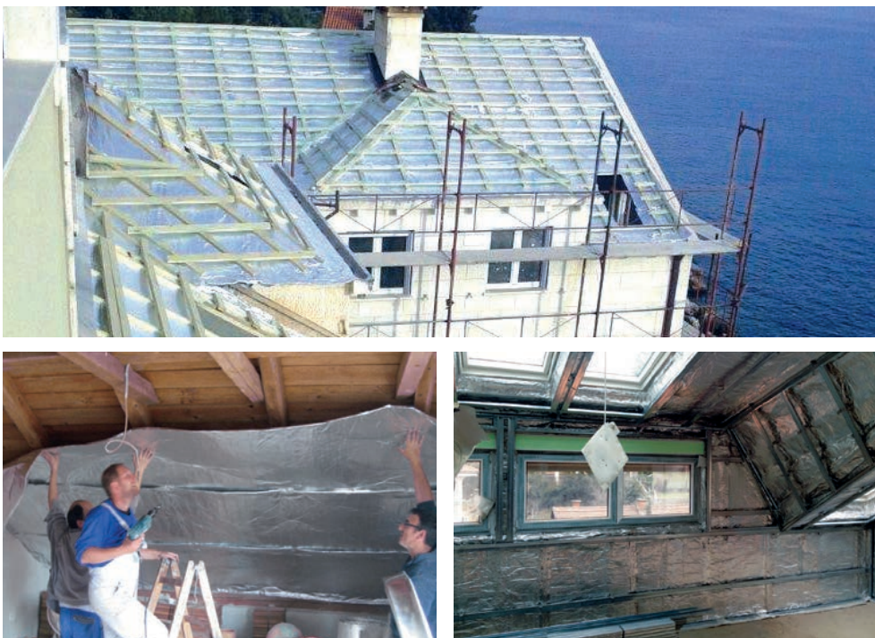
Slika 2-103 Primjer krovišta obloženog reflektirajućom folijom [140]
