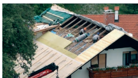
10) Toplinska izolacija postojećeg krova
