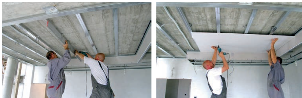
Slika 2-68 Izvedba spušenog stropa s direktnim pričvršćenjem potkonstrukcije [91]
