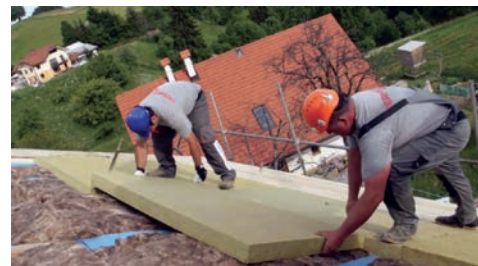
6) Prekrivanje rogova s gornje strane pločama mineralne vune velike čvrstoće
