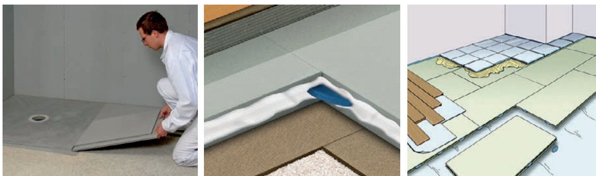
Slika 2-129 Primjeri izvedbe estriha cementnovlaknastim pločama [171], [172], [173]
