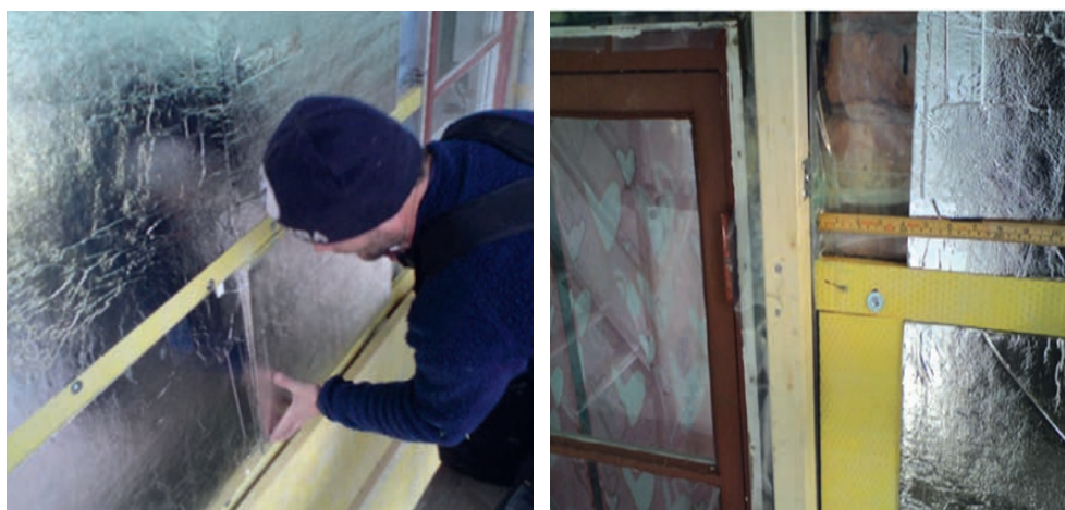
Slika 2-16 Prikaz unutarnje izolacije korištenjem vakumizolacijskih ploča [96]
