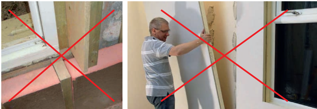
Slika 2-42 Prikaz loše ugradnje sustava unutarnje toplinske izolacije [106], [107]
