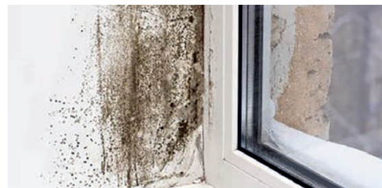
Slika 2-34 Rast gljivica i plijesni zbog kondenzacije na špaleti prozora [102]
