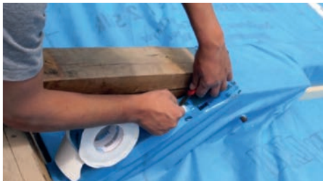
3) Brtvljenje detalja proboja parne brane posebnim trakama za lijepljenje
