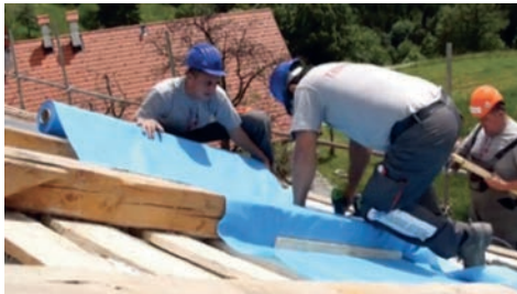
1) Postavljanje parne brane s gornje strane rogova
