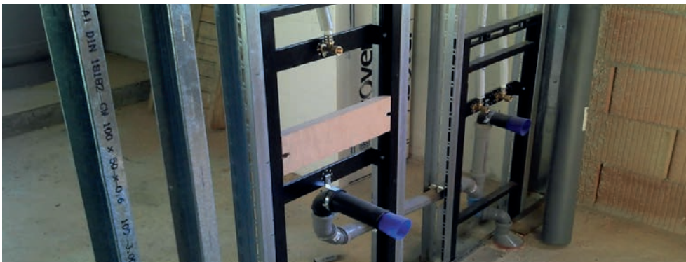
Slika 2-61 Potkonstrukcija za instalacijski zid s nosačima [119]
