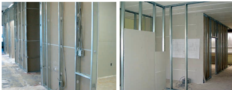
Slika 2-47 Izvedba obloge pregradnog suhomontažnog zida [112]
