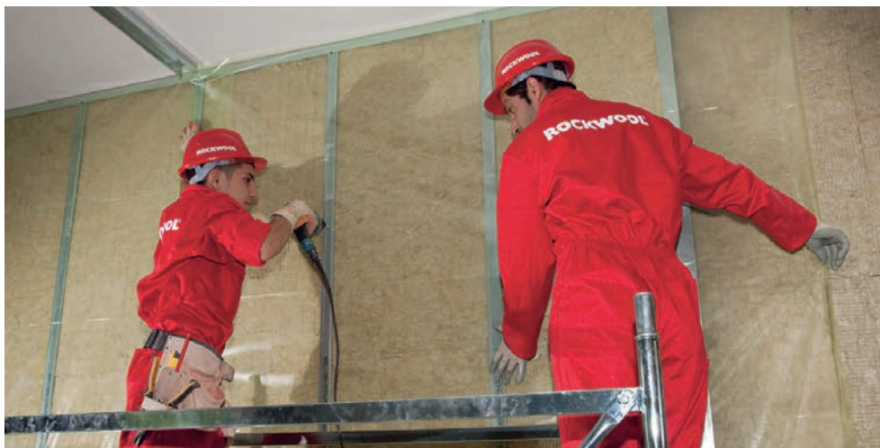
Slika 2-28 Postavljanje parne brane na vanjski zid [1]
