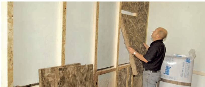
Slika 2-13 Prikaz postavljanja toplinske izolacije od mineralne vune te postavljanje pame brane na drvenu potkonstrukciju [93], [94]
