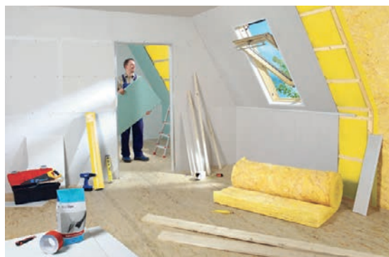
Slika 2-87 Oblaganje potkrovlja suhom gradnjom [130]
