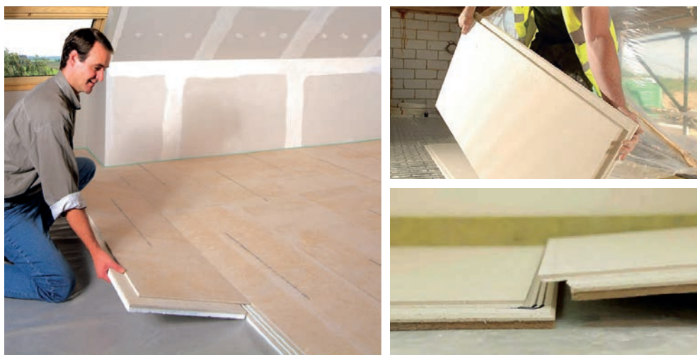
Slika 2-125 Postavljanje višeslojnih gipsvlaknastih ploča direktno na nosivu konstrukciju [91], [99]
