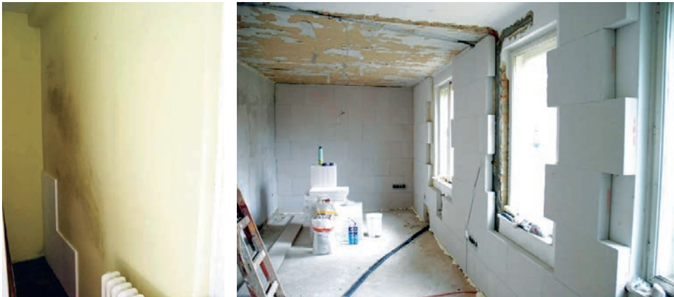
Slika 2-3 Primjeri izolacije s unutarnje strane [85], [86]
