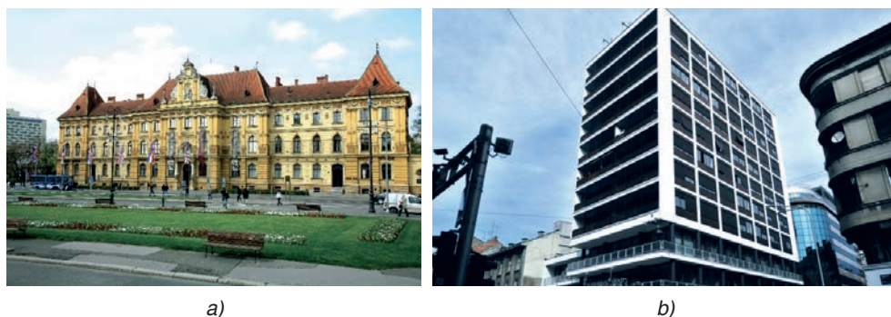
Slika 2-4 Primjeri zaštićene fasade na kojoj nije primjereno izvođenje toplinske izolacije s vanjske strane: a) Muzej za umjetnost i obrt u Zagrebu, b) Iblerov ("drveni") neboder u Zagrebu [87], [88]
