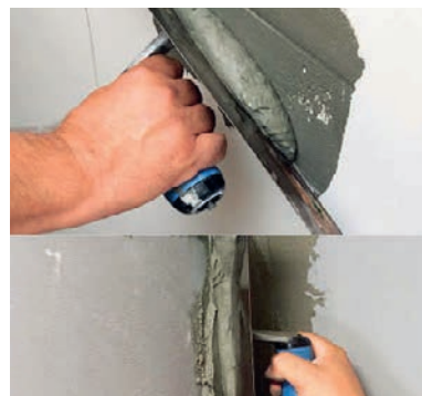
Slika 1-96 Nanošenje glet mase na gletericu [58]
