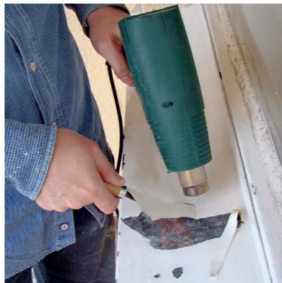
Slika 4-42 Skidanje starog premaza fenom [190]
