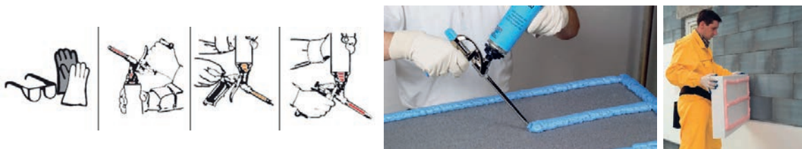
Slika 2-28 PUR ljepilo za EPS ploče [88], [80], [89]
