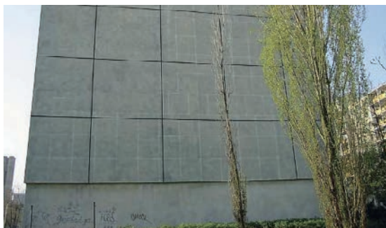
Slika 2-104 Posljedica difuzije vodene pare zbog loše ugradnje ploča EPS-a u ETICS sustav [137]
