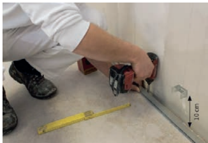
Ugradnja toplinske izolacije
