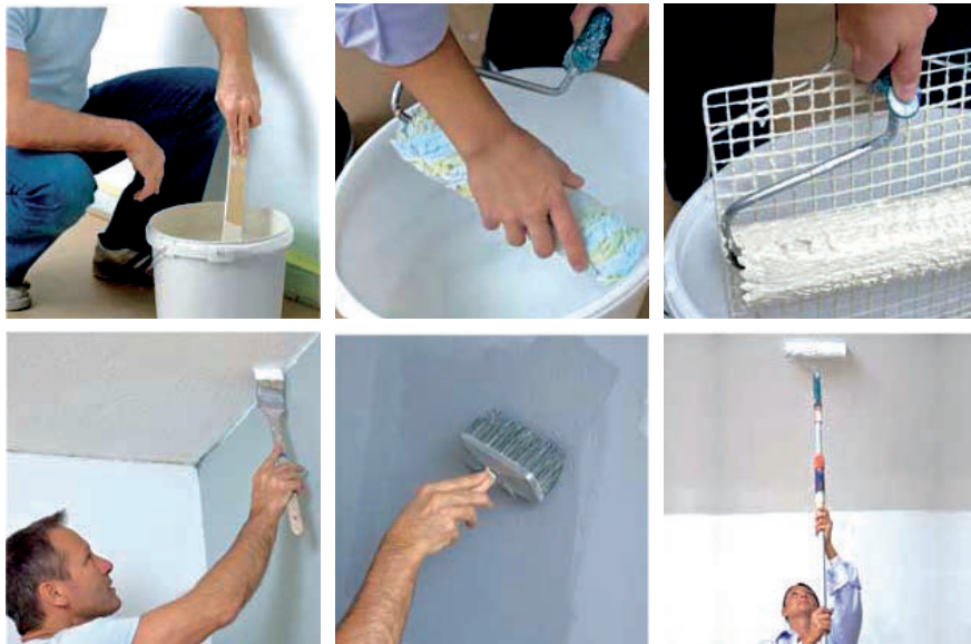
Slika 6-3 Primjer postupka ličenja stropa [201]
