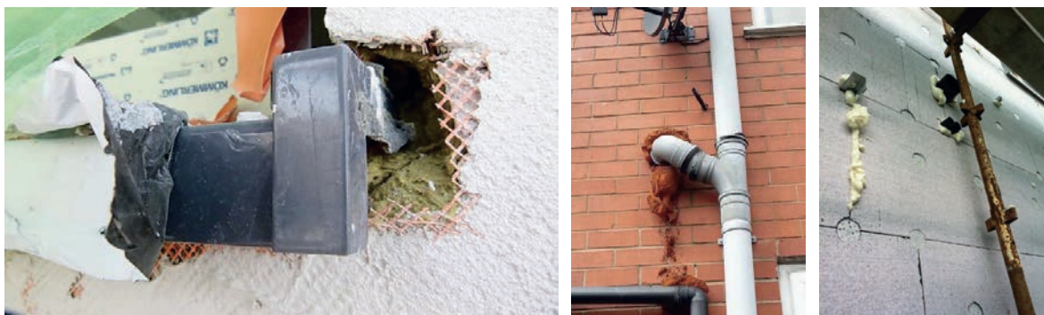
Slika 2-100 Loše izvedeni i nezabrtvljeni prodori ETICS sustava [127], [133], [134]
