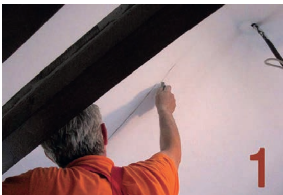
Slika 4-53 Zasjećanje pukotine skalpelom [196]
