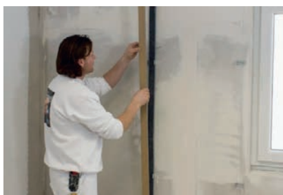
Ugradnja parne brane
