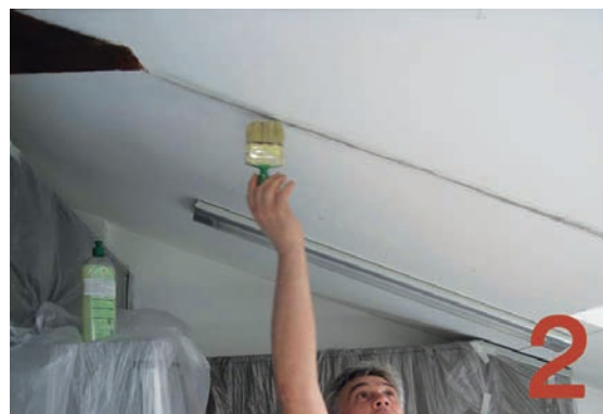
Slika 4-54 Impregniranje temeljnim premazom [196]
