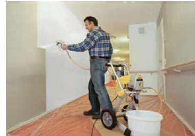
Slika 1-110 Bojanje klipnom pumpom [71]
