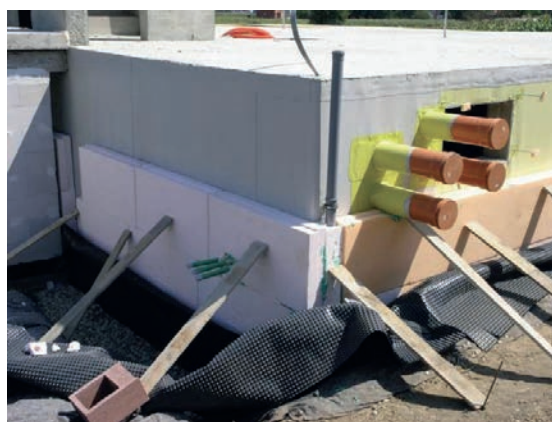
Slika 2-14 Toplinska izolacija zida prema tlu 10]
