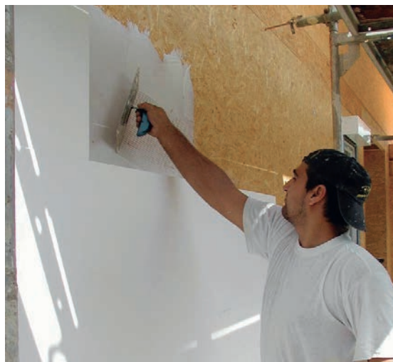
Slika 2-11 Izvedba ETICS sustava na OSB ploče [10]
