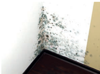
Slika 1-88 Plijesan i gljivice na površini [60]
