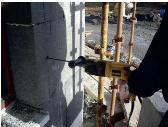
Slika 2-36 Bušenje rupa za pričvrsnice [10]
