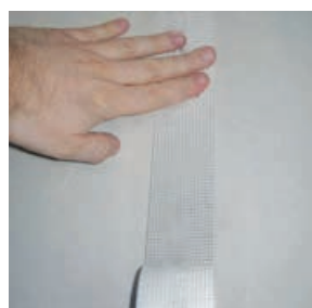
Slika 4-48 Postava bandažne trake na spojeve ploča [190]
