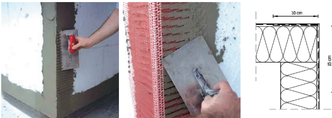
Slika 2-55 Izvedba ruba i kuta pomoću kutnog profila [10] [102]
