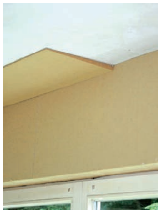
Slika 3-23 Prikaz klina toplinske izolacije susjednih građevnih dijelova [170]
