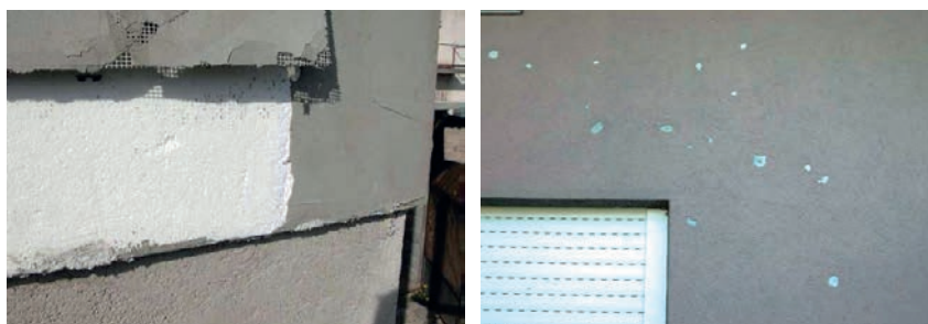
Slika 2-94 Pretanak armaturni sloj [10]
