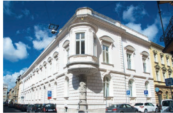
Slika 4-10 Zgrada Hrvatskog inženjerskog saveza u Zagrebu nakon obnove [176]
