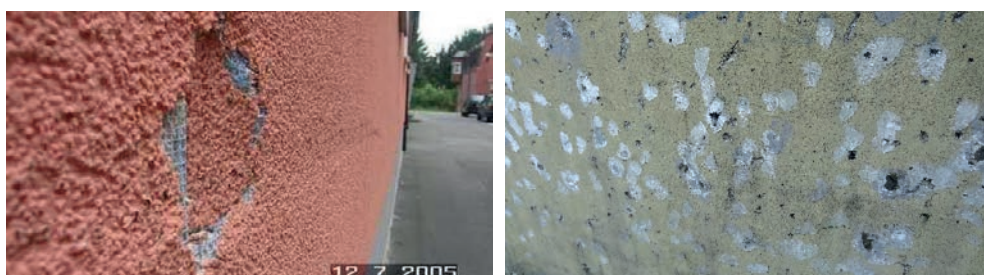
Slika 2-104 Posljedica difuzije vodene pare zbog loše ugradnje ploča EPS-a u ETICS sustav [137]
