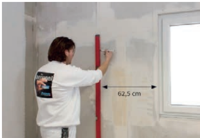
Postavljanje potkonstrukcije, drvene ili metalne
