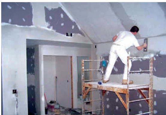
Slika 4-51 Gletanje gipskartonskih ploča [58]
