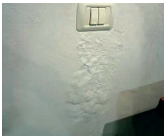
Slika 4-6 Primjer bubrenja žbuke zbog spriječenog isušivanja [174]
