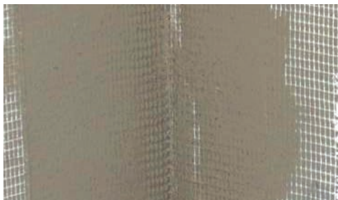
Slika 2-60 Armiranje kutova (a); spoj s doprozornikom (b) [10]
