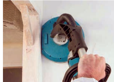
Slika 1-102 Strojno završno brušenje najfinijim papirom [58]
