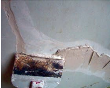
Slika 1-91 Popunjavanje pukotina i rupa [59]
