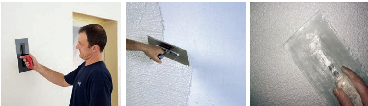
Slika 2-76 Nanošenje završno-dekorativne žbuke [10]
