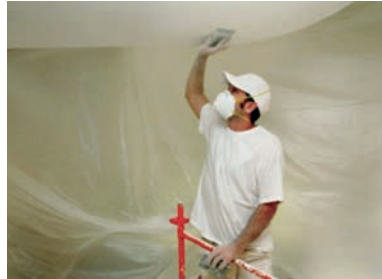
Slika 1-101 Ručno završno fino brušenje [58]
