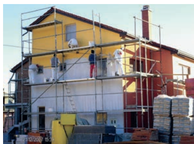
Slika 1-107 Izrada fasade [68]
