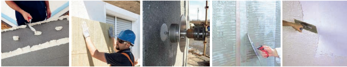
Slika 2-2 Osnovne faze izvođenja ETICS sustava [10]
