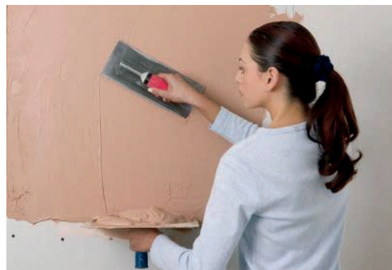
Slika 4-52 Gletanje gipskartonskih ploča [58]
