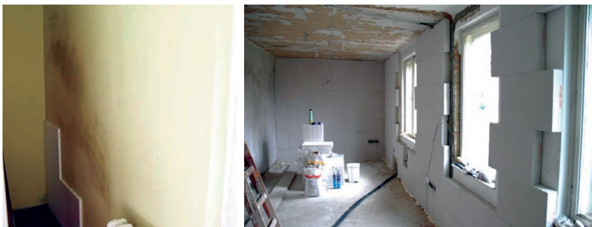
Slika 3-1 Primjeri izolacije s unutarnje strane [151], [152]
