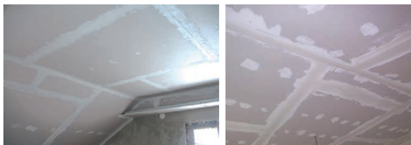
Slika 4-44 Izgled pokitanog plafona [58]
