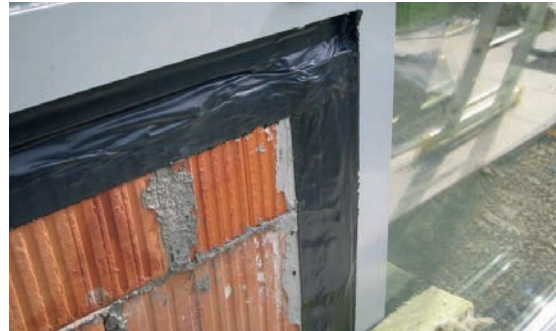
Slika 2-115 Primjer brtvljenja folijom [149]
