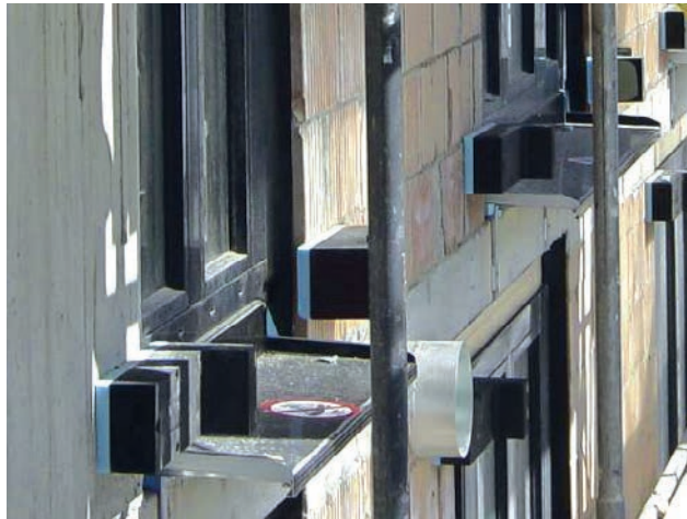
Slika 2-67 Priključivanje dodatnih elemenata za ETICS sustav [107]
