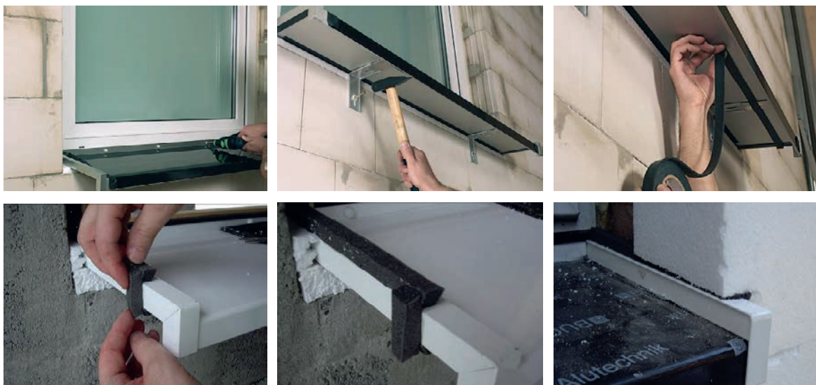
Slika 2-65 Ugradnja i brtvljenje prozorske klupčice [106], [10]
