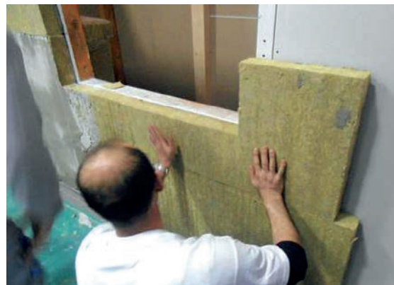
Slika 2 32 Postavljanje toplinskoizolacijske ploče oko prozora – rezanje ploča [10]
