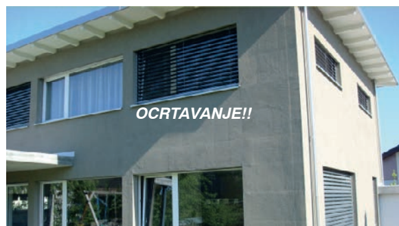
Slika 2-23 Deformacije kod toplinsko-izolacijskih materijala, shematski i primjer lošeg izvođenja [10], [87]
