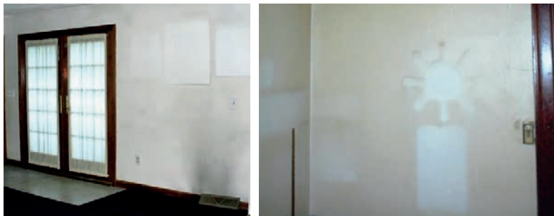
Slika 4-14 Primjeri onečišćenih podloga: a) mrlje od čađe, b) nikotinske mrlje [177]
