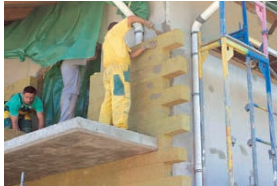
Slika 2-31 Postavljanje toplinsko-izolacijske ploče i lamele na uglovima objekta [10]
