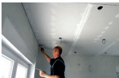
Slika 1-74 Podloga od knauf gips ploča [48]
