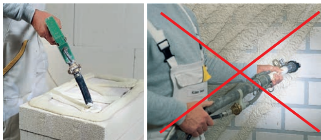
Slika 3-25 Strojno nanošenje morta za lijepljenje „rubno-točkastom“ metodom [10]
