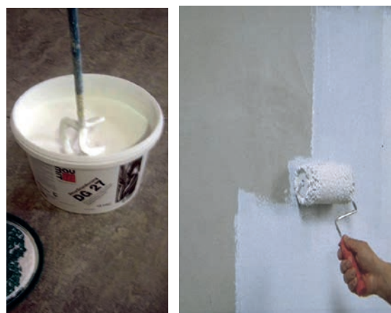
Slika 2-74 Miješanje i nanošenje pretpremaza [10]
