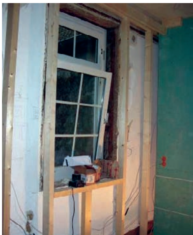
Slika 3-11 Drvena potkonstrukcija za unutarnju izolaciju [159]
