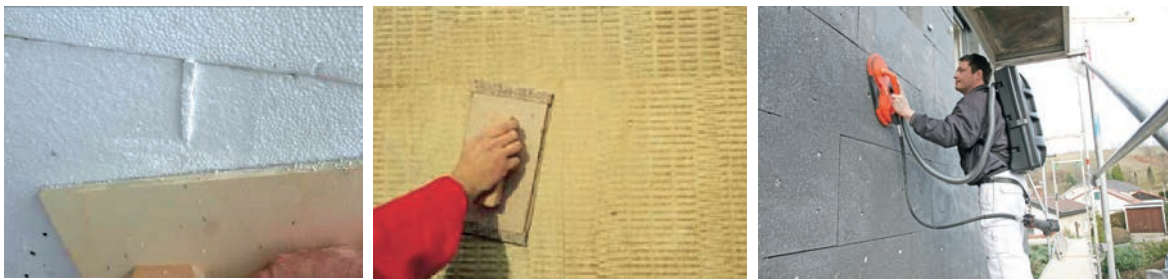
Slika 2-33 Brušenje EPS-a i mineralne vune [10]
