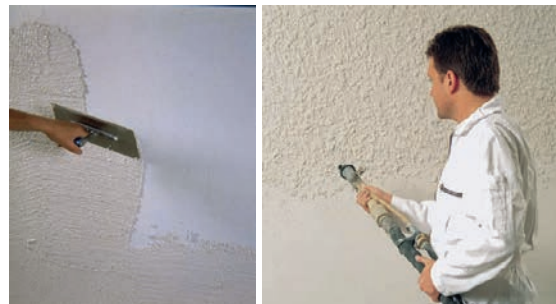
Slika 2-10 Nanošenje završno dekorativne žbuke [82], [10]
