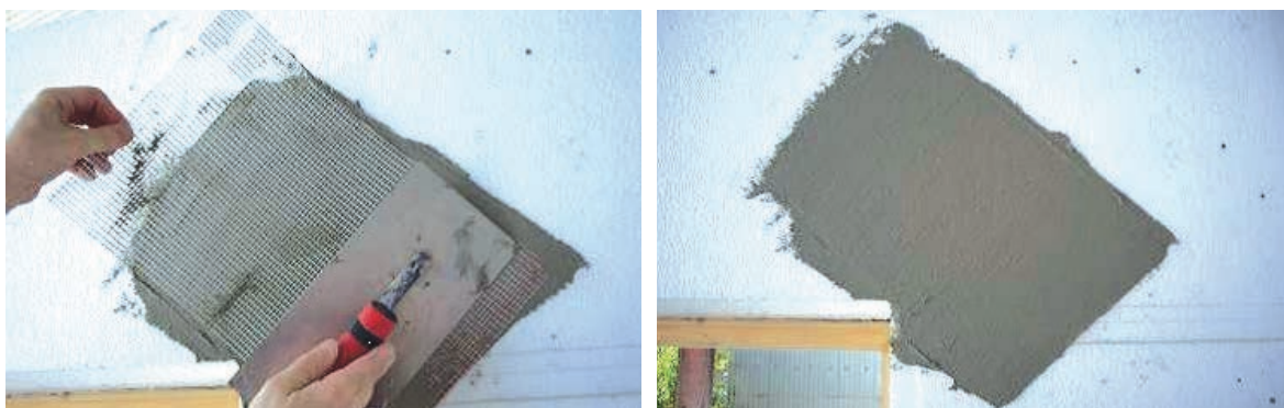
Slika 2-51 Dijagonalno armiranje uglova prozora [10]
