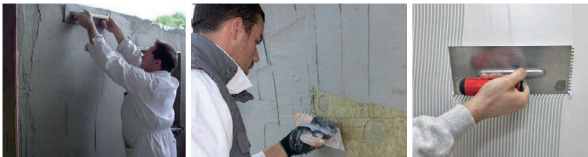
Slika 2-48 Nanošenje morta za armaturni sloj [10], [92]
