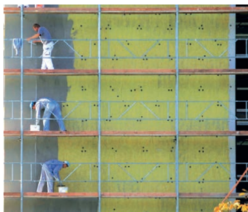
Slika 2-29 Postavljanje toplinsko-izolacijske ploče i lamela [10]
