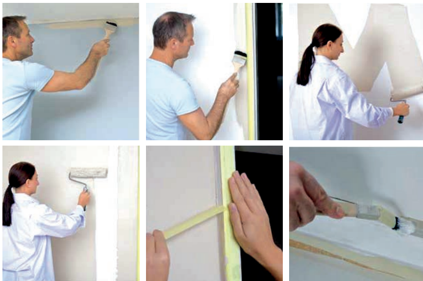
Slika 6-4 Primjer postupka ličenja zida [201]
