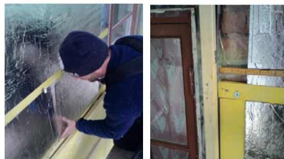
Slika 3-17 Prikaz unutarnje izolacije korištenjem vakumizolacijskih ploča [163]
