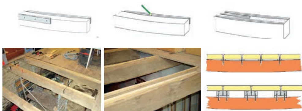
Slika 3-120 Primjer izravnanja progiba postojeće drvene grede [297]
