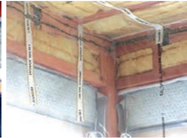
Slika 3-140 Prikaz ugrađenih prozora s pripremom za nastavak parne brane [13]
