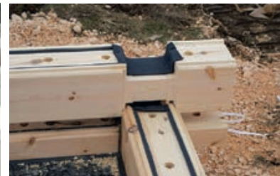
Slika 2-23 Postizanje zrakonepropusnosti poliuretanskim brtvama [161]
