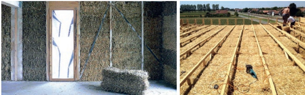
Slika 4-4 Drvena konstrukcija s ispunom od slame [354], [355]
