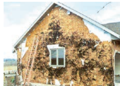
Slika 6-14 Truljenje drvene konstrukcije zbog sušenja vanjske obloge zgrade prema unutra uslijed djelovanja sunca [388]
