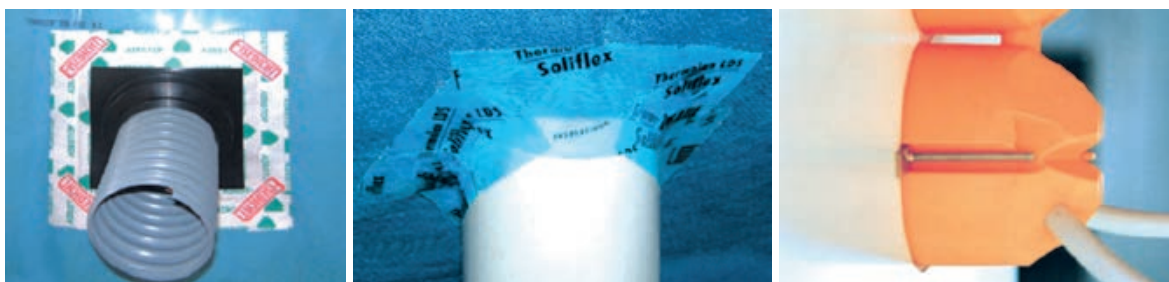
Slika 3-53 Primjeri brtvljenja proboja zrakonepropusne barijere [248]
