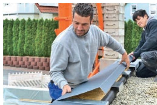
Izvođenje limarskih radova oko atike
