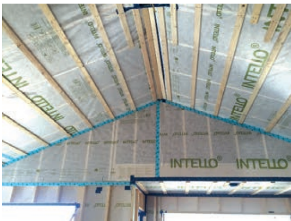
Slika 3-51 Primjer ostvarenja zrakonepropusne ovojnice korištenjem folija [253], [254], [255]
