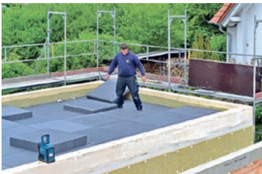
Postavljanje drugog sloja toplinske izolacije
