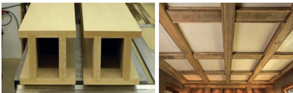
Slika 1-86 Drvene sandučaste grede [97], [98]
