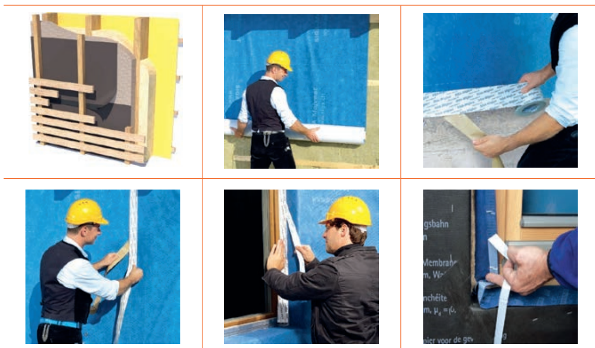
Tablica 3-6 Primjer postavljanja paropropusno-vodonepropusne folije na drvenu potkonstrukciju ventilirane fasade drvene zgrade [266]
