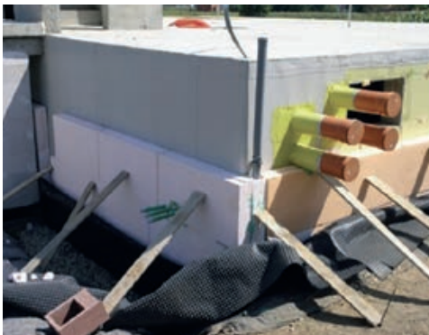
Slika 3-9 Prikaz izvođenja perimetarske toplinske izolacije betonskog temelja korištenjem XPS-a [171]
