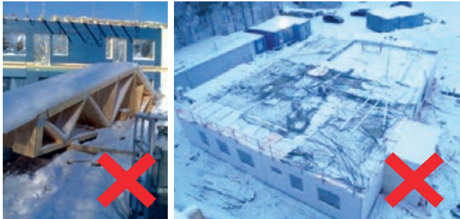
Slika 2-71 Primjeri nezaštićenih drvenih konstrukcija tijekom gradnje
