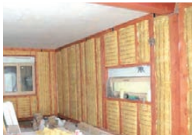
Slika 2-28 Ispuna kanatne stijene s toplinskom izolacijom te izvedba parne brane s unutarnje strane [171]
