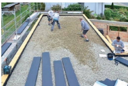
Zaštita hidroizolacije sa šljunkom
