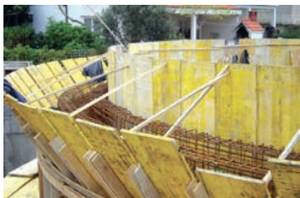
Slika 1-1 Izrada oplata [1]
