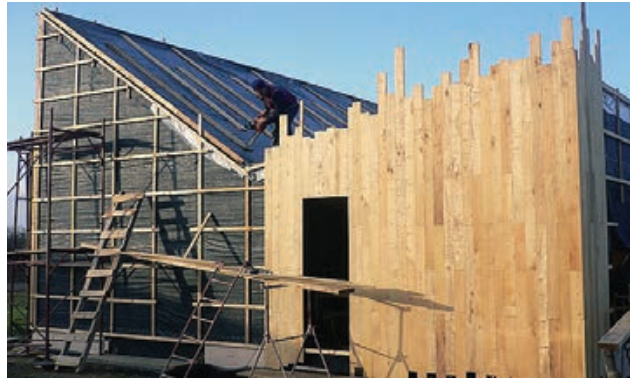
Izvođenje paropropusno-vodonepropusne folije ispod završne obloge
