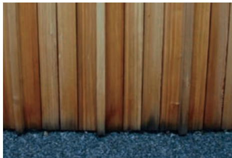
Slika 3-80 Prikaz vertikalne završne obloge bez izvedenog podnožja; promjena boje drva vidljiva je već nakon kratkog vremena [217]
