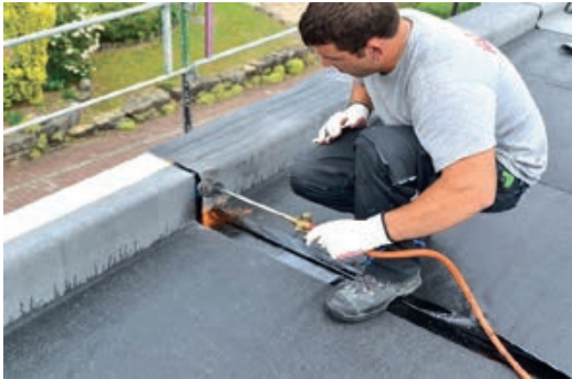
Postavljanje parne brane varenjem
