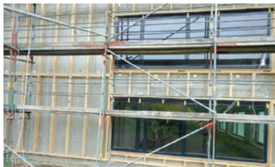
Slika 3-63 Drvena potkonstrukcija ventilirane fasade na AB zidu [262]
