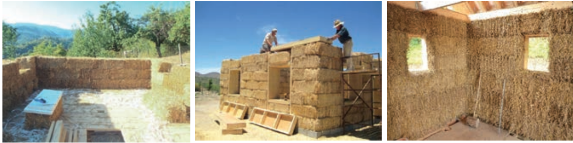
Slika 4-3 Nosivi zid od bala slame [346], [352], [353]
