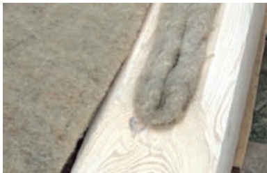
Slika 2-22 Korištenje ovčje vune za postizanje zrakonepropusnosti [161]
