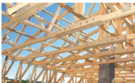
Slika 2-6 Vezovi vertikalnog produženja i njegova primjena u drvenoj konstrukciji [107], [13]
