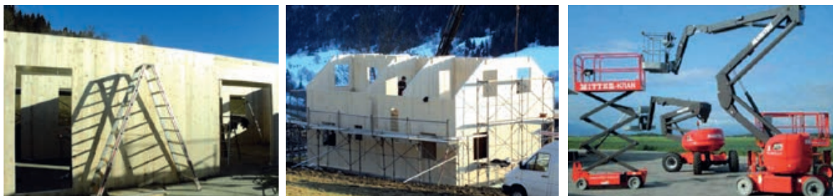
Slika 2-74 Pomagala za postizanje situacije za montažu i/ili fiksiranje, ljestve, skela, platforma [203]
