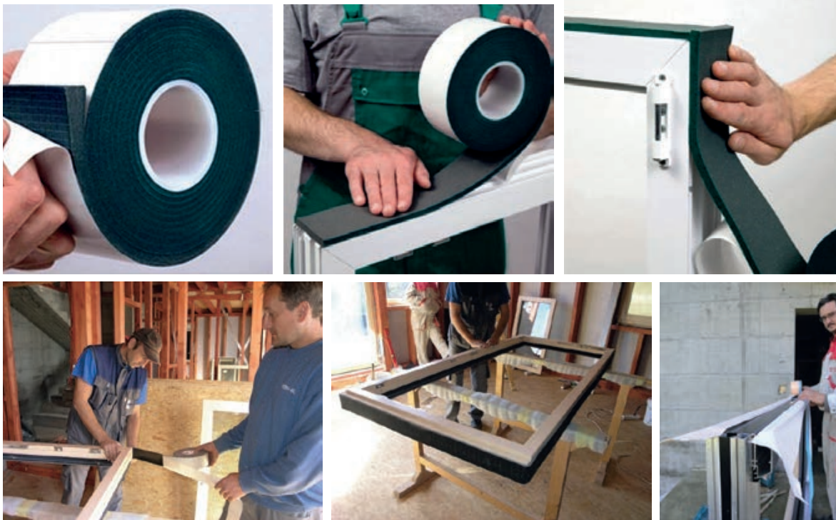
Slika 3-136 Brtvljenje pomoću brtvenih traka [305], [171]
