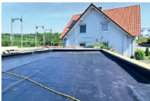
Postavljena hidroizolacijska membrana
