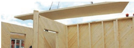
Tablica 2-1 Transport i montaža panela: cijeli panel – vanjski zid (1); unutarnji panel (2) [186]
