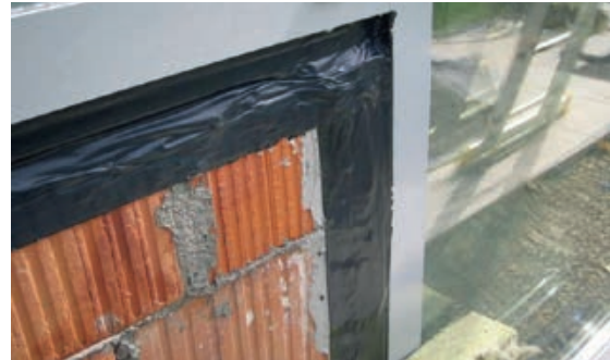
Slika 3-135 Primjer brtvljenja folijom [306]
