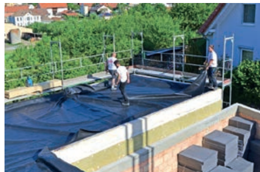
Razvlačenje hidroizolacijske membrane
