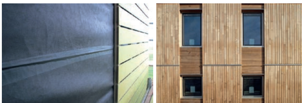
Slika 3-70 Drvena fasadna obloga na kišnoj brani [269], [270]
