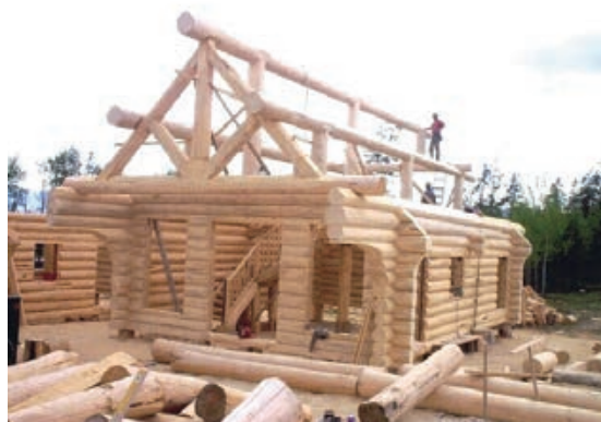
Slika 1-57 Gradnja kuće od oble građe [67]
