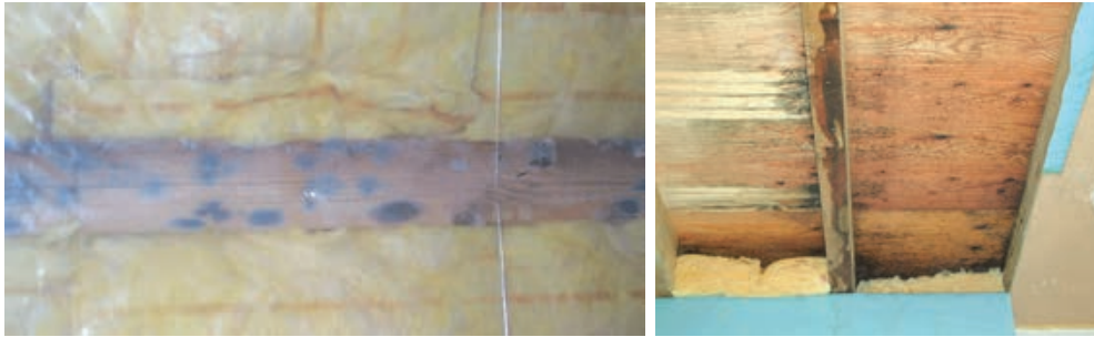
Slika 6-3 Stvaranje gljivica i plijesni zbog loše izvedene parne brane [398]
