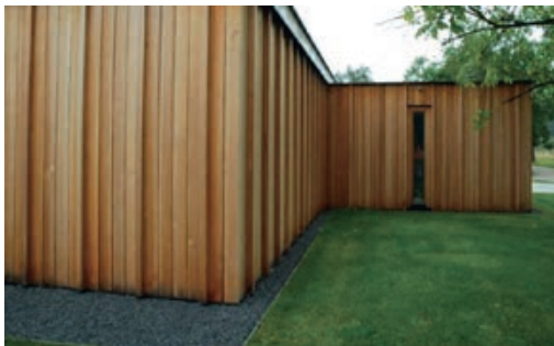
Slika 3-80 Prikaz vertikalne završne obloge bez izvedenog podnožja; promjena boje drva vidljiva je već nakon kratkog vremena [217]
