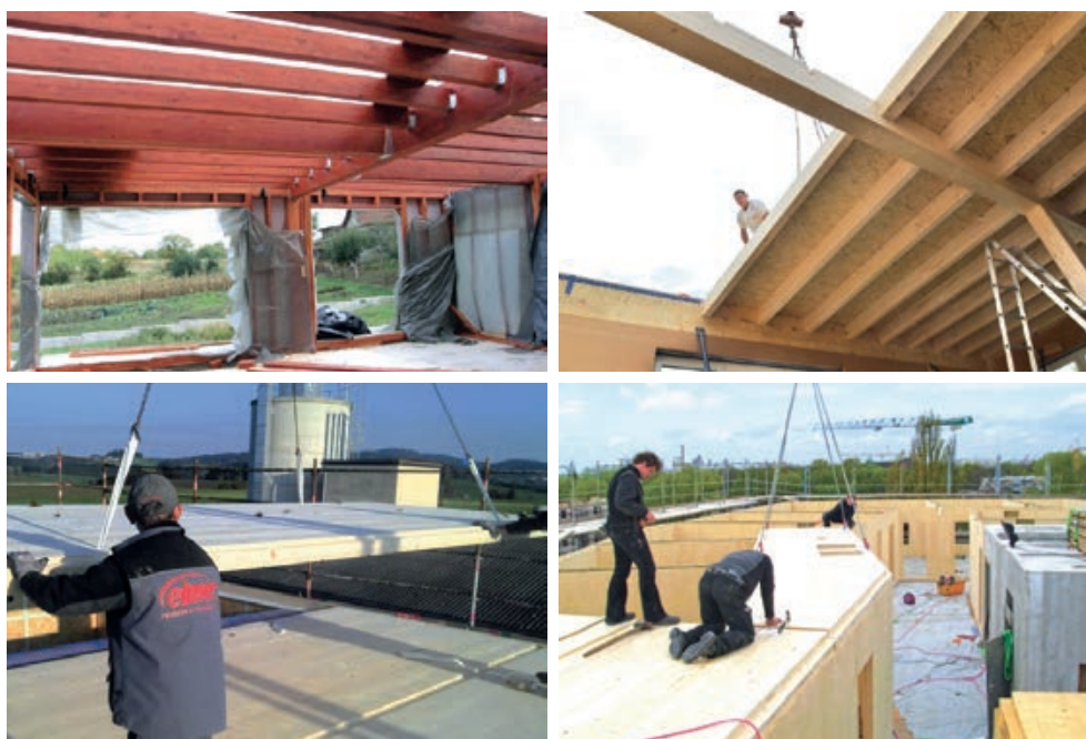
Slika 3-203 Fotografije tipova nosivih konstrukcija ravnog krova drvenih zgrada [12], [277], [341], [342]
