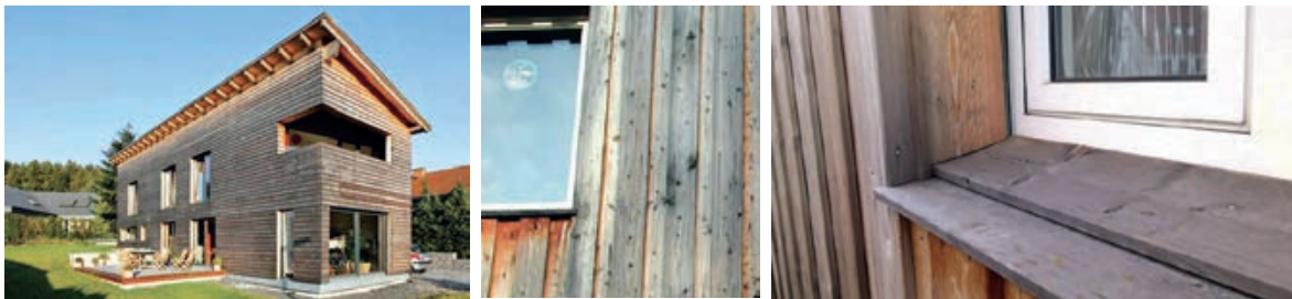
Slika 6-9 Diskoloracija drva uslijed djelovanja UV zračenja [398], [404]
