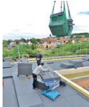
Postavljanje toplinske izolacije
