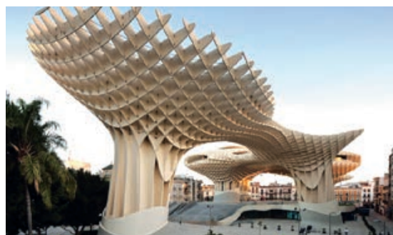
Slika 1-53 Najveća drvena konstrukcija na svijetu [63]
