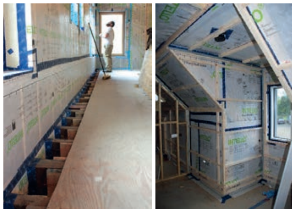
Slika 3-51 Primjer ostvarenja zrakonepropusne ovojnice korištenjem folija [253], [254], [255]
