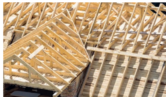
Slika 2-48 Aksonometrijski prikaz drvene krovne konstrukcije [194]
