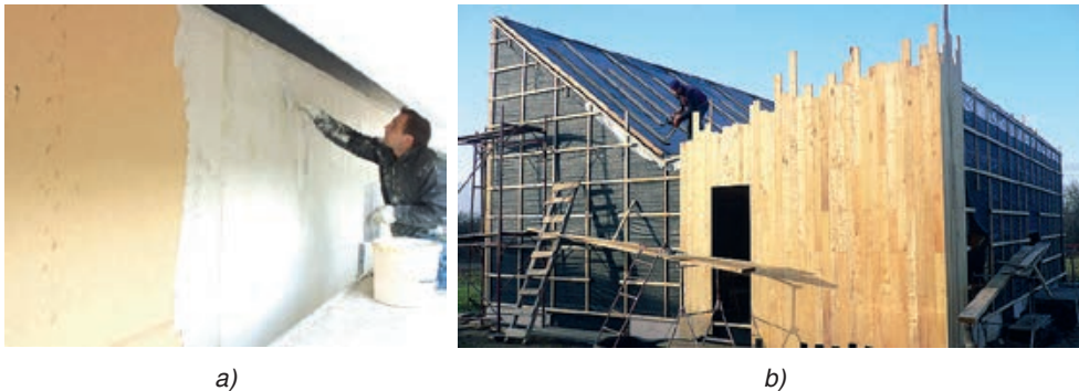
Slika 3-25 Primjeri dodatne vanjske izolacije drvene kuće: a) izvođenjem ETICS sustava te b) izvođenjem ventilirane fasade [235], [236]
