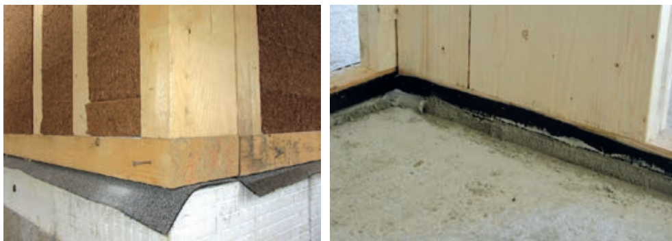
Slika 3-3 Prikaz napuštanja hidroizolacije ispod drvenog zida zbog izvođenja preklopa [218], [210]
