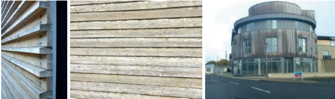
Slika 6-8 Loše održavana drvena vanjska obloga [401], [402], [403]
