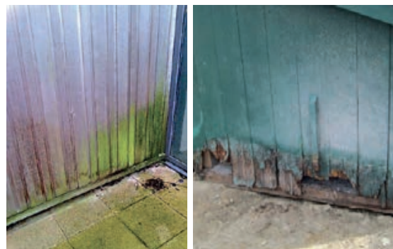
Slika 6-11 Nakupljanje algi i truljenje obloge zbog neodgovarajućeg održavanja podnožja zgrade [406]
