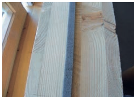
Uska jednostrano ljepljiva elastična brtvena traka
