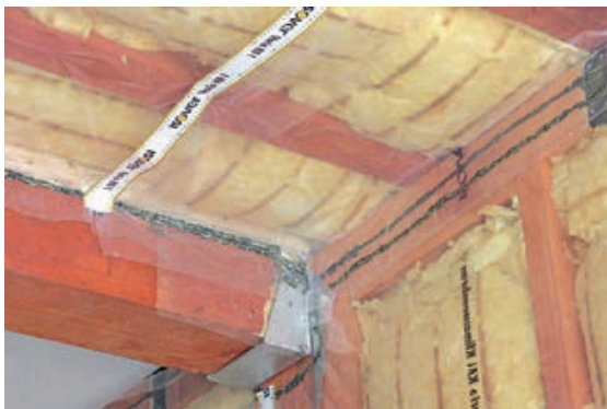
Slika 3-49 Primjena jednostrano ljepljive trake i specijaliziranog ljepila za postizanje zrakonepropusnosti [171]
