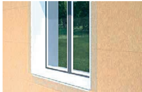
Korak 4: Ugradnja prozora u sloj toplinske izolacije
