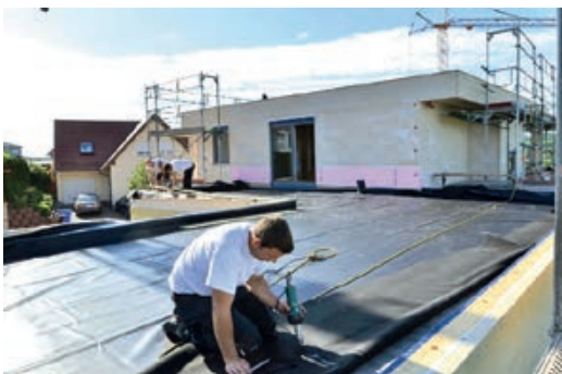
Međusobno varenje hidroizolacijske membrane
