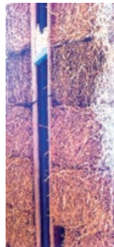
Slika 4-17 Električne instalacije u zidu od slame: a) postavljanje razvodne kutije; b) “rabic” mreža protiv glodavaca i za armiranje žbuke; c) vodiči u bužirima; d) instalacije vodovoda i odvodnje [346], [373], [374], [375]
