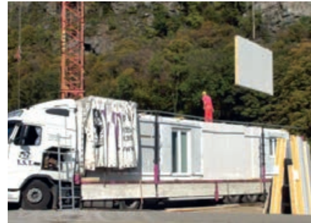
Slika 2-72 Primjer zaštite drvenih panela tijekom prijevoza [106]
