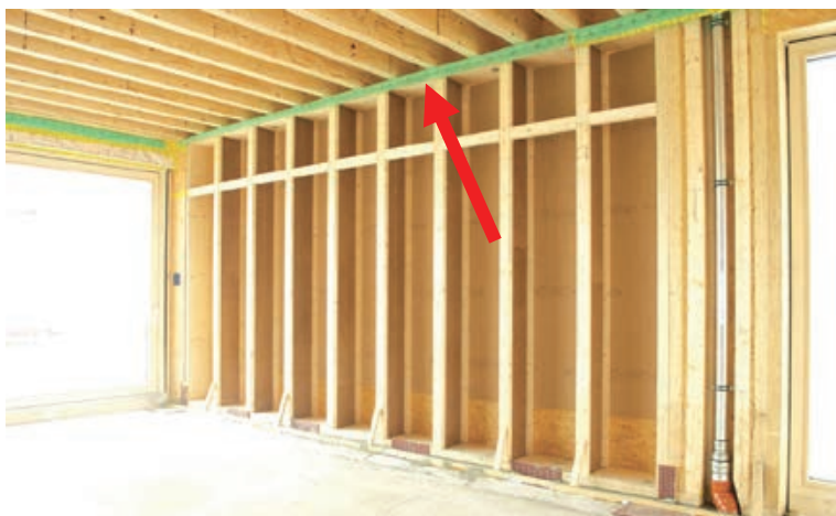
Slika 3-45 Montirana drvena konstrukcija s pripremljenim detaljem ostvarivanja [249] kontinuirane parne brane (zelena traka u stropu)
