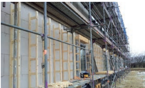
Slika 3-62 Drvena potkonstrukcija ventilirane fasade na zidanoj konstrukciji [261]
