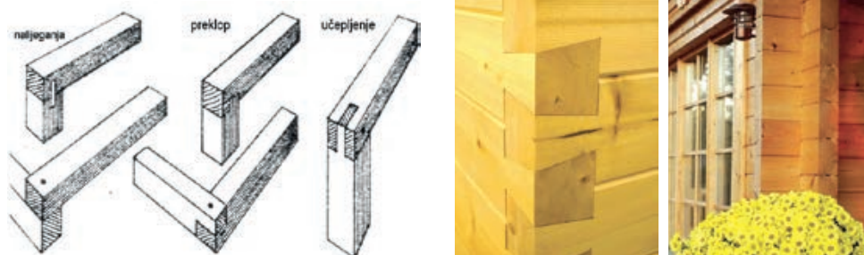
Slika 2-10 Vezovi uglova i njihova primjena na punoj drvenoj stijeni [148], [154], [155]
