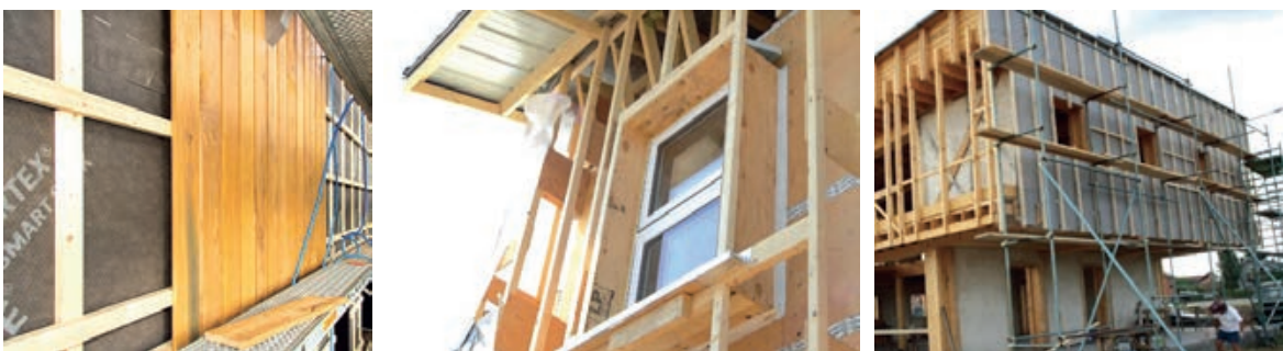
Slika 3-66 Potkonstrukcija i zračni sloj ventilirane fasade [264], [263], [265]
