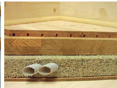
Slika 3-16 Suvremena rješenja poda na tendenciji plivajućih [224]
