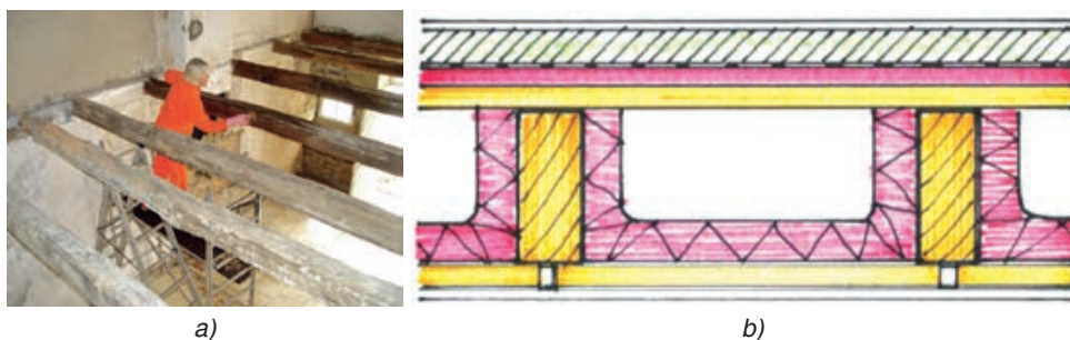
Slika 3-123 Primjer sanacije stropa od drvenih grednika [297]
