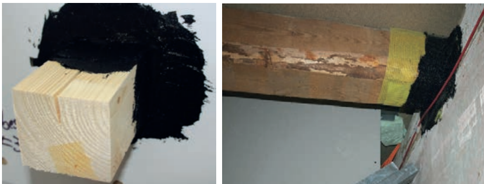
Slika 3-57 Primjeri brtvljenja proboja korištenjem gustog bitumenskog premaza [247]
