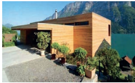
Slika 2-3 Trajna nosiva drvena konstrukcija [146]
