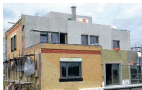
Izvođenje ETICS sustava na drvenu konstrukciju
