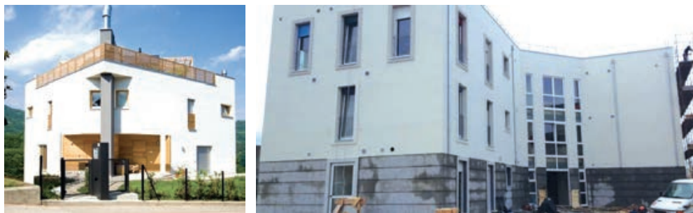
Slika 3-42 Drvena kuća s ETICS sustavom i bez dilatacijske fuge u razini međukatnog spoja [245]
