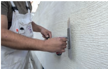
Izvođenje završne dekorativne žbuke ETICS sustava
