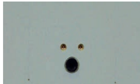
Obloga priključka za perilicu korištenjem vodootpornih gipskartonskih ploča
