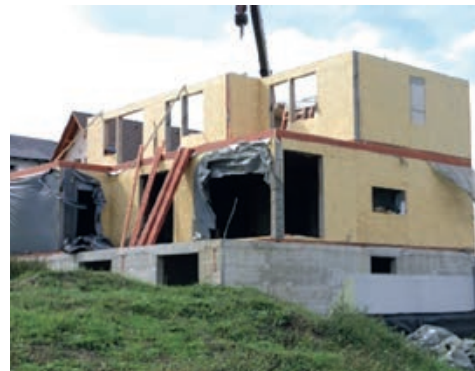
Slika 3-9 Prikaz izvođenja perimetarske toplinske izolacije betonskog temelja korištenjem XPS-a [171]
