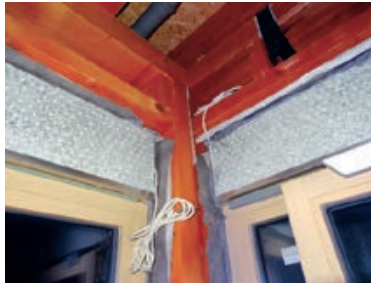
Slika 3-140 Prikaz ugrađenih prozora s pripremom za nastavak parne brane [13]
