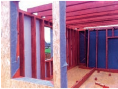
Slika 3-139 Prikaz otvora s pripremom za nastavak kišne brane [13]
