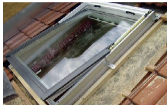
Slika 3-160 Učvršćivanje krovnog prozora [313]
