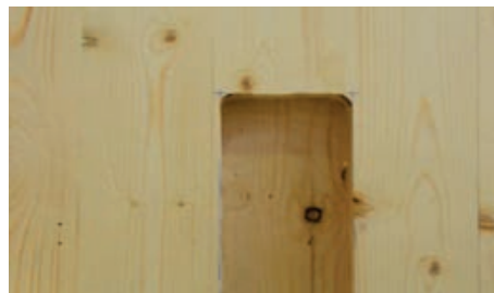
Primjer urezane niše za dovod cijevi radijatora
