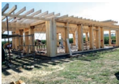
Slika 2-27 Primjer drvene kuće građene kanatnim sustavom [170]
