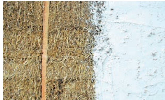
Slika 4-18 Žbukanje ispune od slame korištenjem vapnene žbuke [376]
