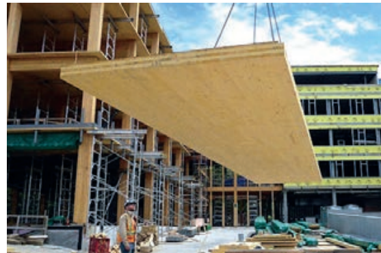
Slika 1-73 Primjer upotrebe križno lameliranih ploča u višestambenoj zgradi [81]
