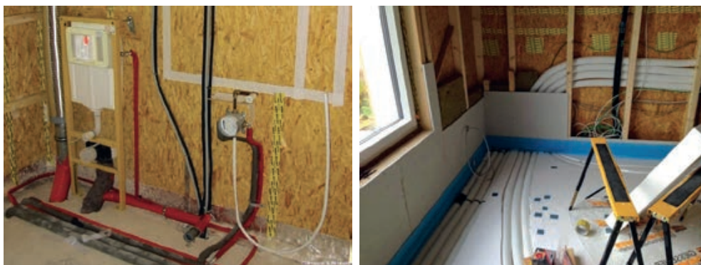
Slika 3-88 Prikaz instalacija u drvenoj kući [286], [287]
