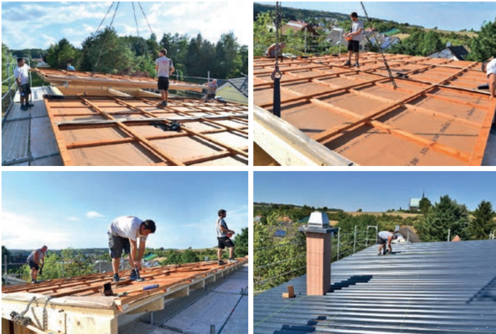
Slika 3-194 Primjer izvedbe ventiliranog krova s pokrovom od trapeznog lima korištenjem predgotovljenih krovnih elemenata [251]
