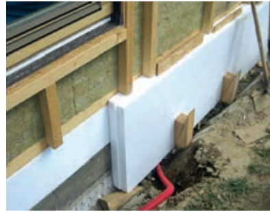
Slika 3-7 Prikaz izvođenja perimetarske toplinske izolacije betonskog temelja [221]
