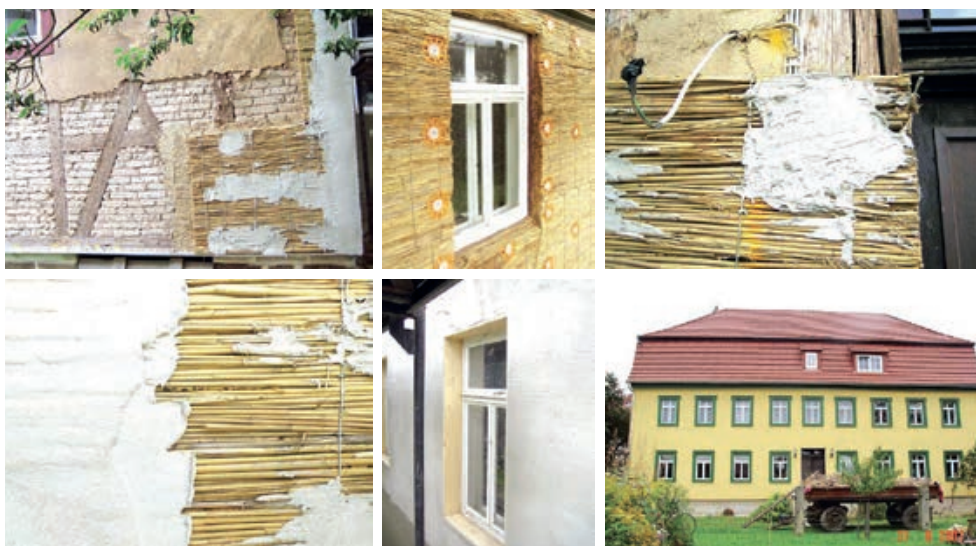
Slika 4-26 Primjer korištenja trstike za vanjsku izolaciju kod obnove fasade postojeće zgrade iz 1780. godine [386]
