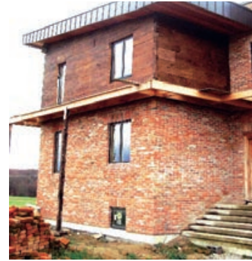
Slika 2-21 Tradicionalna drvena građa reciklirana (presložena) i korištena u novogradnji pasivne kuće; autor: Lj. Mišćević [13]
