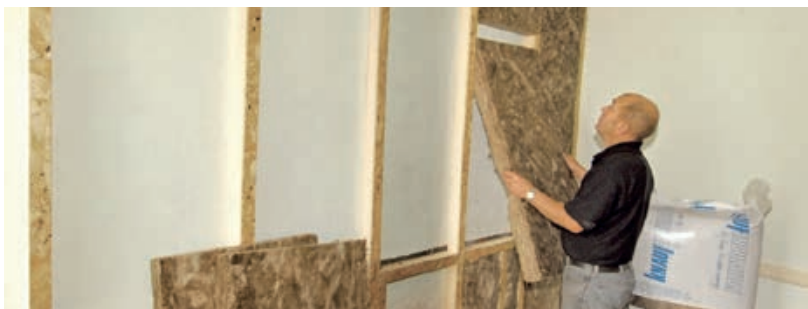
Slika 3-92 Prikaz postavljanja toplinske izolacije od mineralne vune te postavljanje parne brane na drvenu potkonstrukciju [290], [291]
