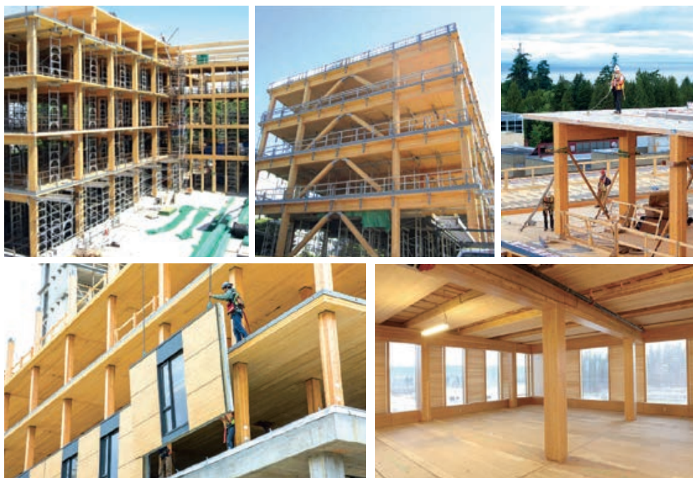
Slika 2-32 Izgled skeletnog sustava i elementi stijene [174], [175], [176], [177]
