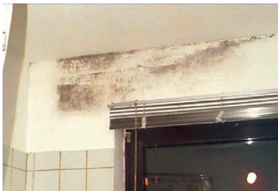
Slika 4-102 Fotografija građevinske štete uzrokovane toplinskim mostom [127]
