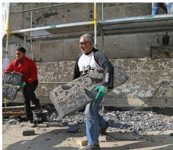
Slika 1-15 Zbrinjavanje toplinske izolacije [32]
