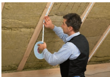
Primjena obostrano ljepljive trake
