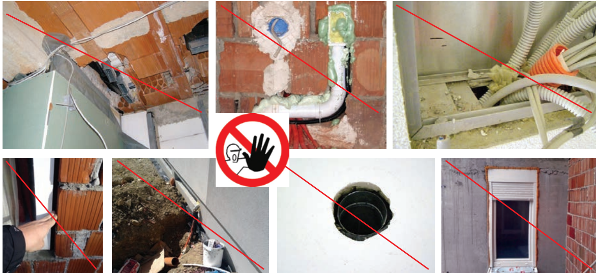
Slika 5-11 Primjeri lošeg izvođenja građevinskih radova – potencijalna slaba mjesta na vanjskoj ovojnici zgrade [11]
