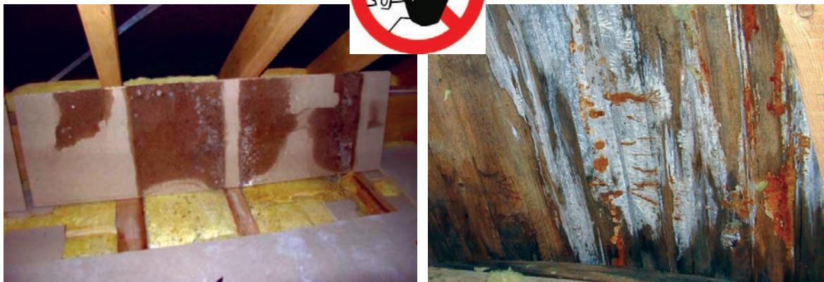
Slika 5-10 Vlaženje i truljenje materijala uslijed kondenzacije vodene pare [11]
