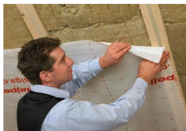
Lijepljenje parne brane (paro i zrakonepropusne folije)
