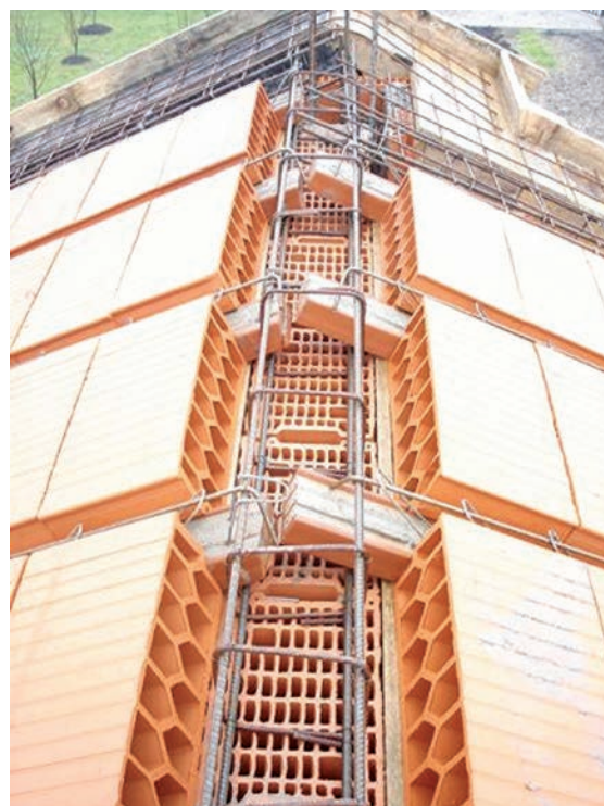
Slika 4-81 Masivni kosi krov – Fert strop [108]
