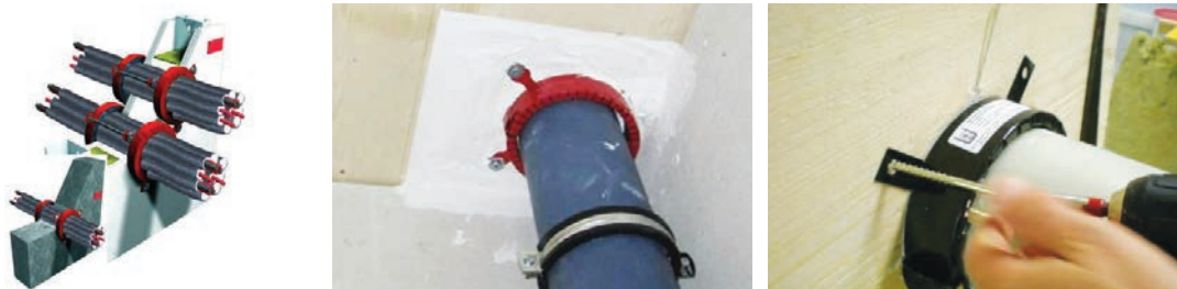
Slika 5-22 Brtvljenje proboja kroz konstrukciju instalacijom manšete [170]
