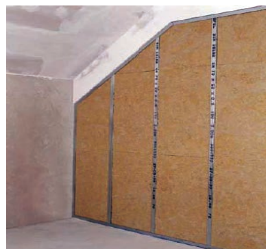
Slika 4-53 Pregradni zidovi od gipskartonskih ploča [92]
