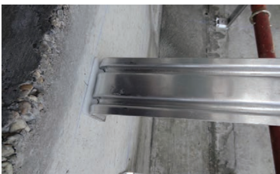
Slika 4-115 Prekid toplinskog mosta kod nosača ventiliranih fasada [11]
