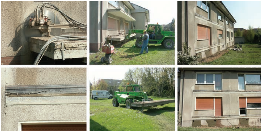
Slika 4-124 Uklanjanje AB balkona u svrhu energetske obnove
