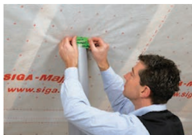
Brtljenje proboja-pola trake na foliju, a pola na cijev
