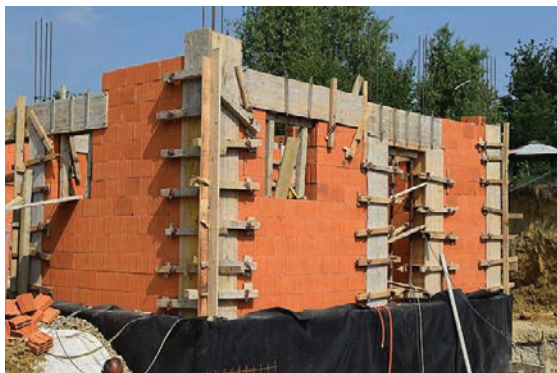
Slika 4-66 Monolitni AB nadvoj [102]
