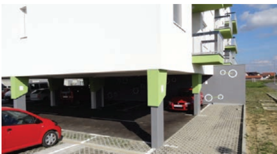
Slika 4-58 Betonski stup izoliran za sprječavanje toplinskog mosta [11]
