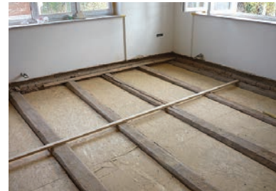
Slika 4-65 Strop od drvenih grednika [101]
