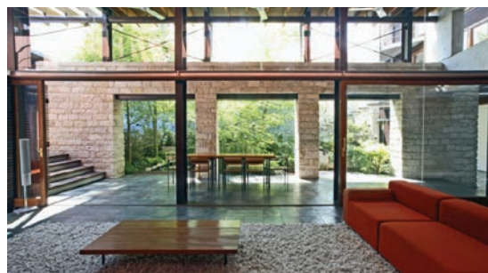
Slika 4-59 Čelični i kameni stupovi [96]
