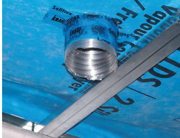
Slika 5-4 Izvedena parna brana [31]
