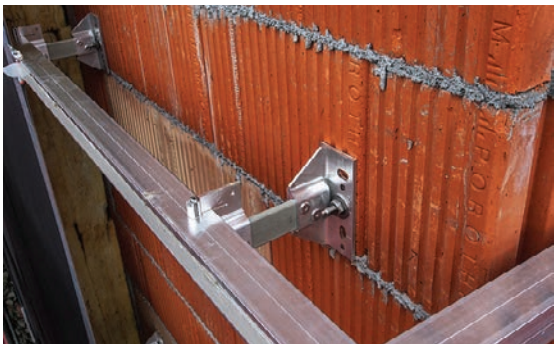
Slika 4-113 Prekid točkastih toplinskih mostova kod ventiliranih fasada [11]
