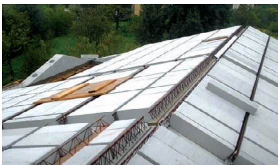
Slika 4-80 Masivni kosi krov – Bijeli strop [111]
