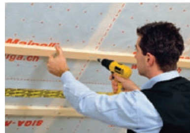
Pričvršćenje potkonstrukcije za oblogu gipskartonskim pločama
