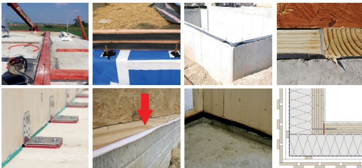
Slika 5-19 Brtljenje spojeva drvene konstrukcije [165], [167], [166], [168]
