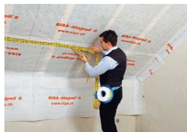
Lijepljenje međusobnih spojeva plati folije - preklapanje barem 10 cm
