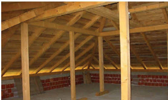
Slika 4-79 Drvena krovna konstrukcija [110]
