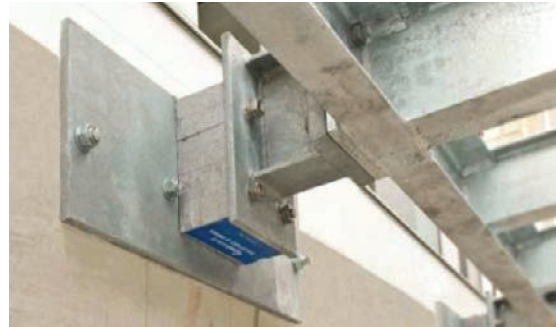
Slika 4-128 Predgotovljeni čelični balkon ugrađen na postojeći zid [130]
