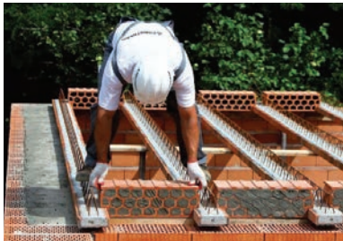
Slika 4-63 Fert strop [99]
