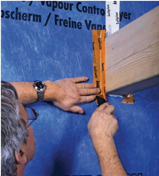
Slika 5-5 Lijepljenje parne brane specijalnim ljepljivim trakama [31]
