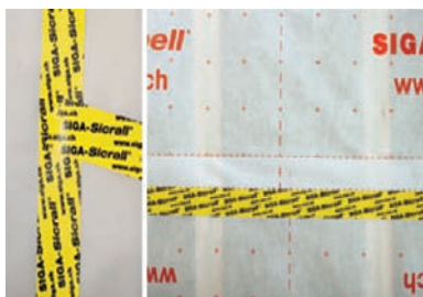
Izgled spoja nakon lijepljenja jednostrano ljepljivim trakama
