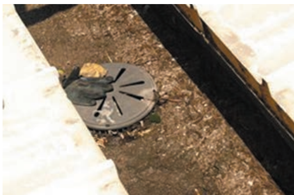
Slika 3-247 Začepljena rešetka sifona na krovu i oštećenja na krovnoj hidroizolaciji [207]
