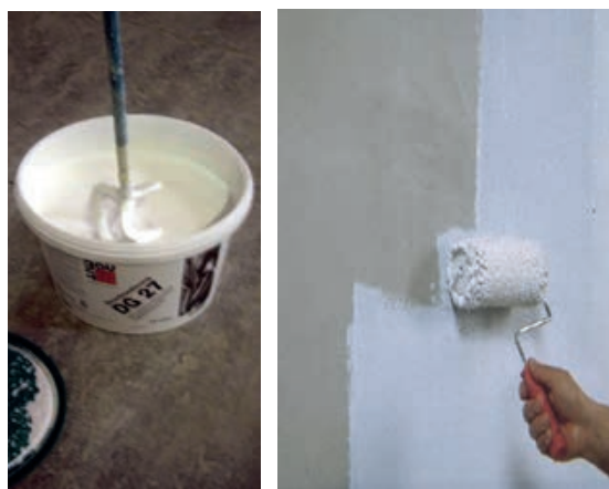
Slika 3-133 Miješanje i nanošenje predpremaza
