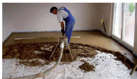
Slika 1-4 Izvedba podnih podloga [4]
