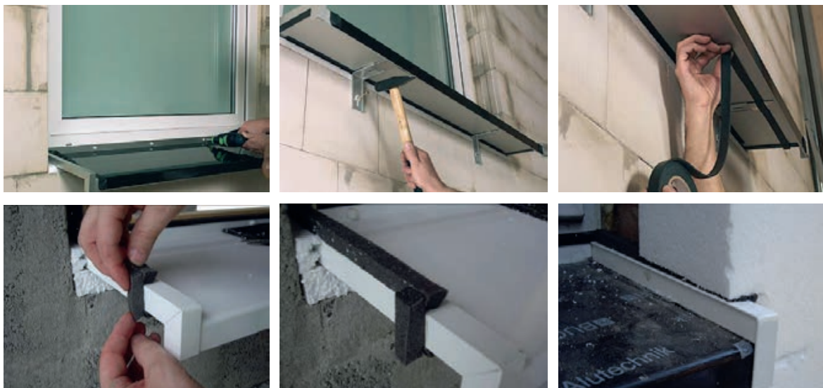
Slika 3-124 Ugradnja i brtvljenje prozorske klupčice [135], [9]
