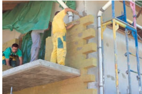
Slika 3-90 Postavljanje toplinsko-izolacijske ploče i lamele na uglovima objekta [9]
