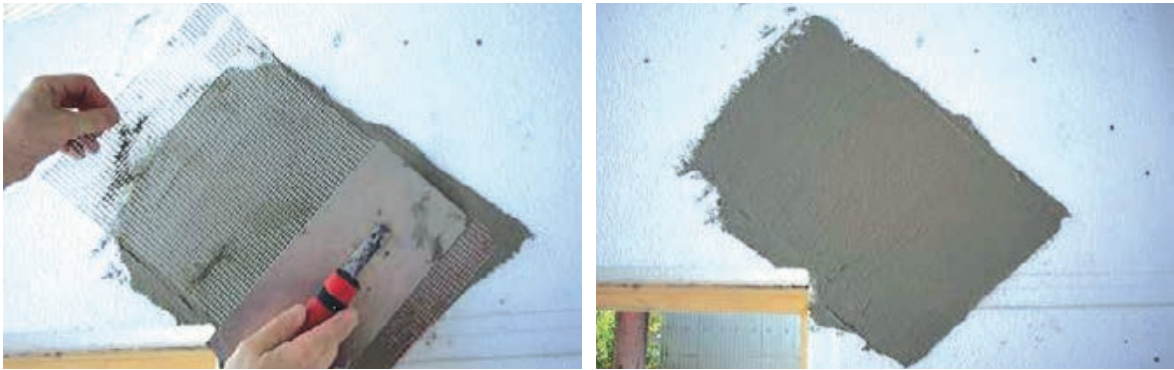
Slika 3 -110 Dijagonalno armiranje uglova prozora [9]
