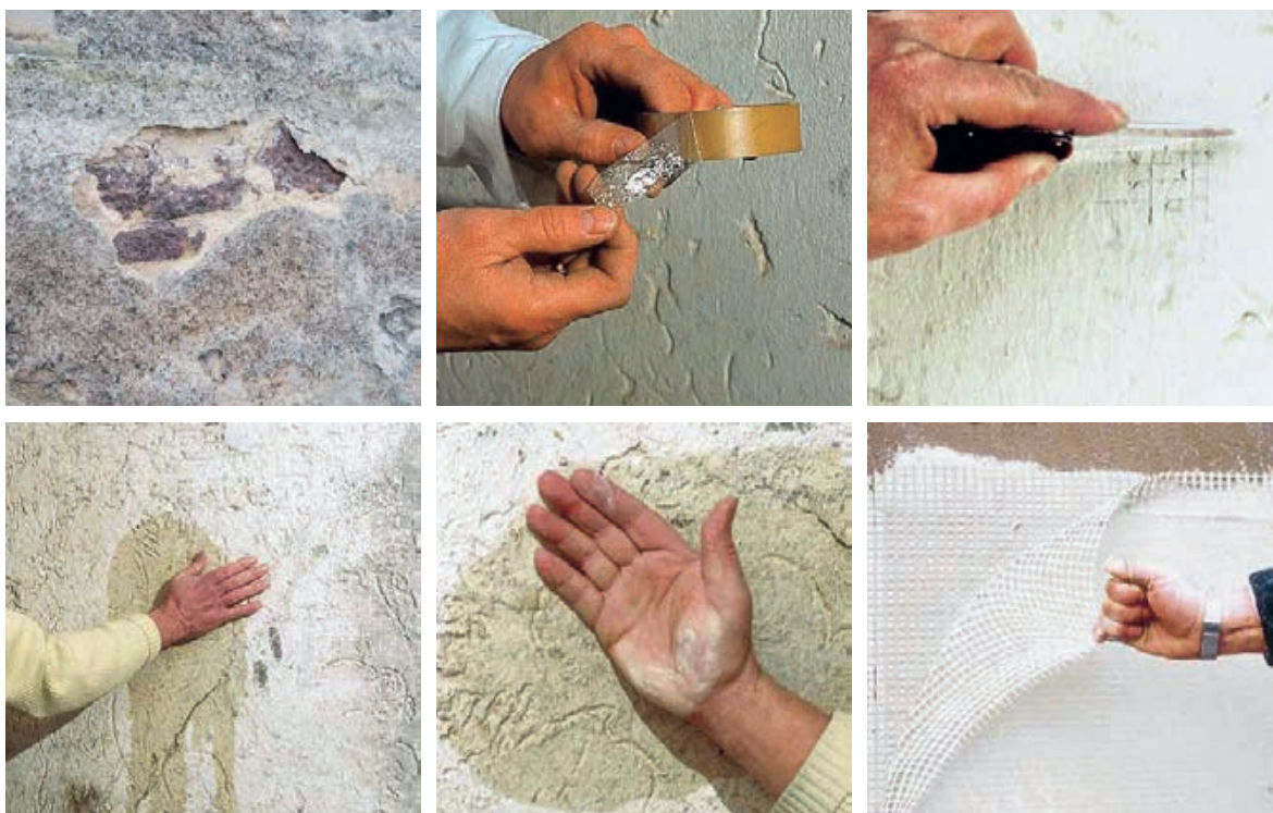
Slika 3-71 Načini ispitivanja postojeće žbuke prije izvođenja novog ETICS sustava [9]
