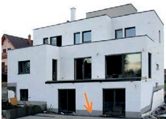
Slika 3-78 Podnožje u ravnini s pročeljem i odvojenim / različitim završnim slojem [9]
