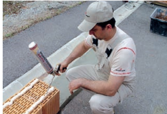
Slika 2-7 Nanošenje poliuretanskog ljepila [48]
