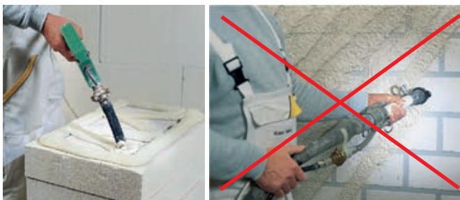
Slika 3-84 Strojno nanošenje morta za lijepljenje „rubno-točkastom“ metodom [9]
