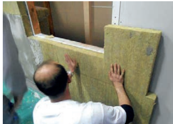
Slika 3-91 Postavljanje toplinsko-izolacijske ploče oko prozora – rezanje ploča [9]
