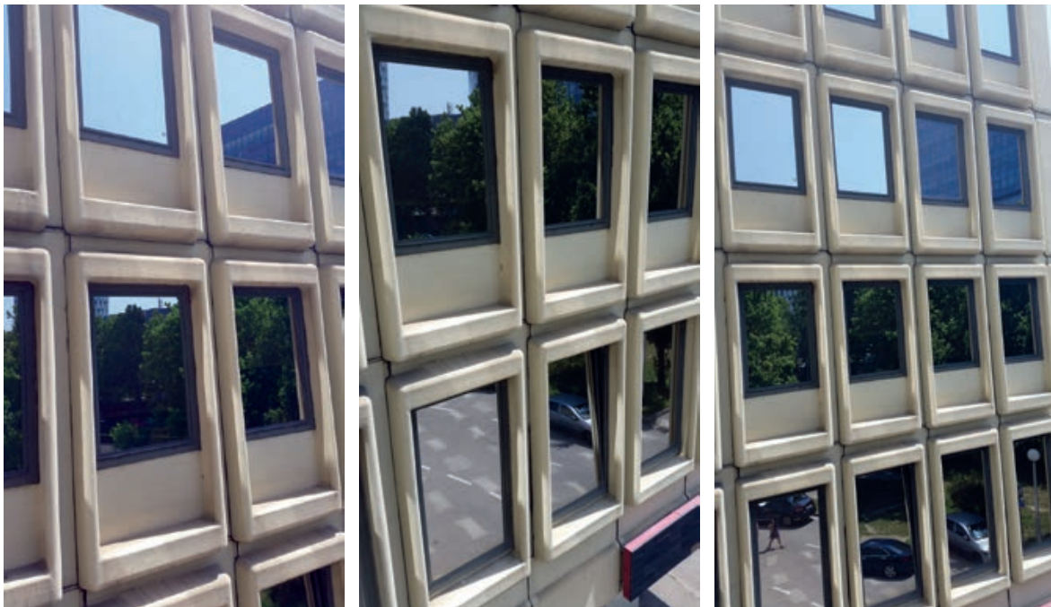
Slika 3-194 Brtvljeni predgotovljeni betonski elementi [56], [184]
