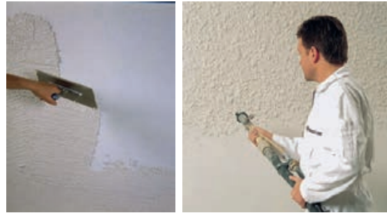
Slika 3-69 Nanošenje završno dekorativne žbuke [111], [9]
