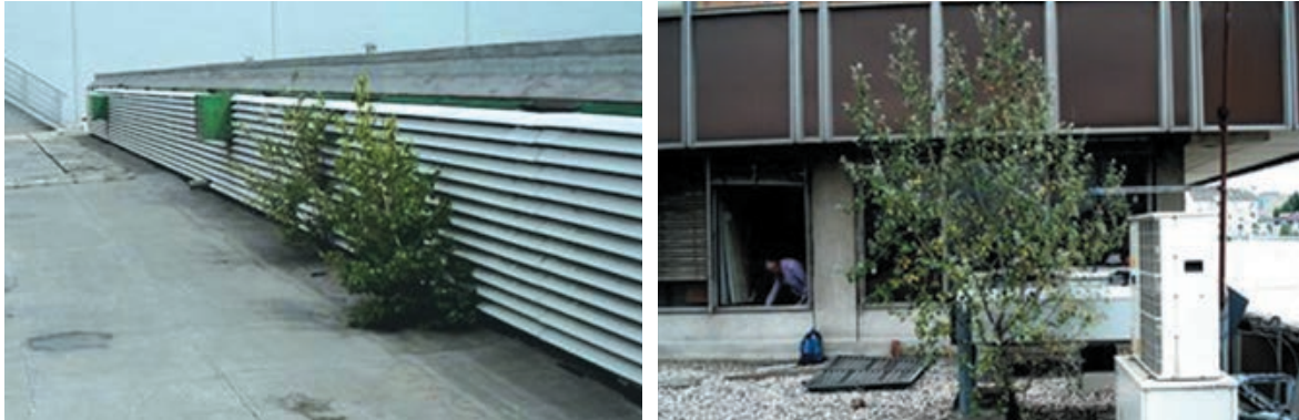
Slika 3-248 Primjeri lošeg održavanja krova [207]
