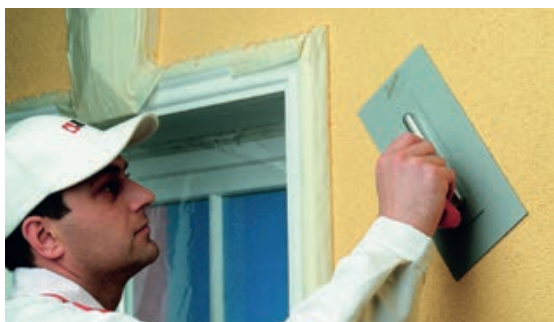
Slika 1-3 Fasadno žbukanje [3]
