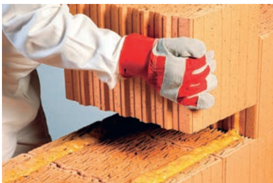
Slika 1-112 Postava drugog sloja opeke [48]
