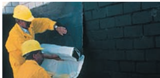
Slika 1-103 Postava hidroizolacije [76]
