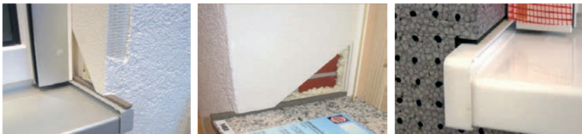
Slika 3-125 Izgled spoja ETICS sustava i prozorske klupčice [9]
