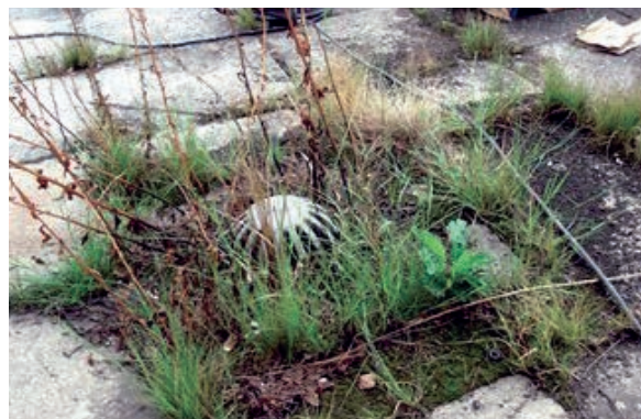
Slika 3-245 Otpad na krovu i lišćem začepljeni slivnik [207]
