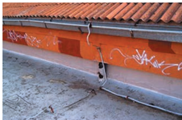
Slika 3-247 Začepljena rešetka sifona na krovu i oštećenja na krovnoj hidroizolaciji [207]
