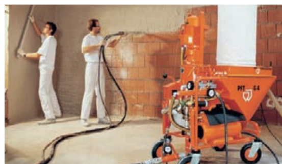
Slika 1-2 Unutarnje žbukanje [2]
