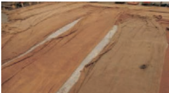
Slika 1-78 Primjena jutenih pokrivača [67]
