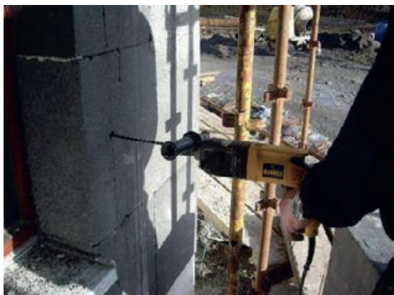
Slika 3-95 Bušenje rupa za pričvrsnice [9]
