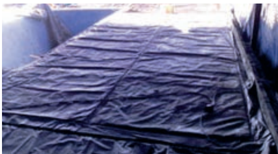
Slika 1-80 Prekrivanje geotekstilom [69]
