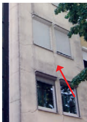
Slika 3-152 Neodgovarajuće ugrađen ETICS sustav
