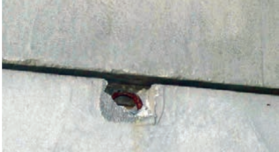
Slika 3-192 Usadna kuka, koja omogućava ugradnju panela [184]
