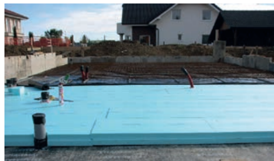
Slika 3-48 TI temeljne ploče [104]
