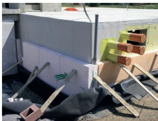
Slika 3-73 Toplinska izolacija zida prema tlu [9]
