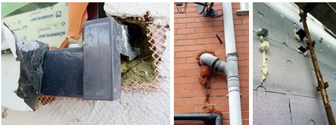
Slika 3-159 Loše izvedeni i nezabrtvljeni prodori ETICS sustava [158], [164], [165]
