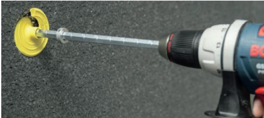
Slika 3-64 Dodatno mehaničko pričvršćivanje toplinske izolacije [9]
