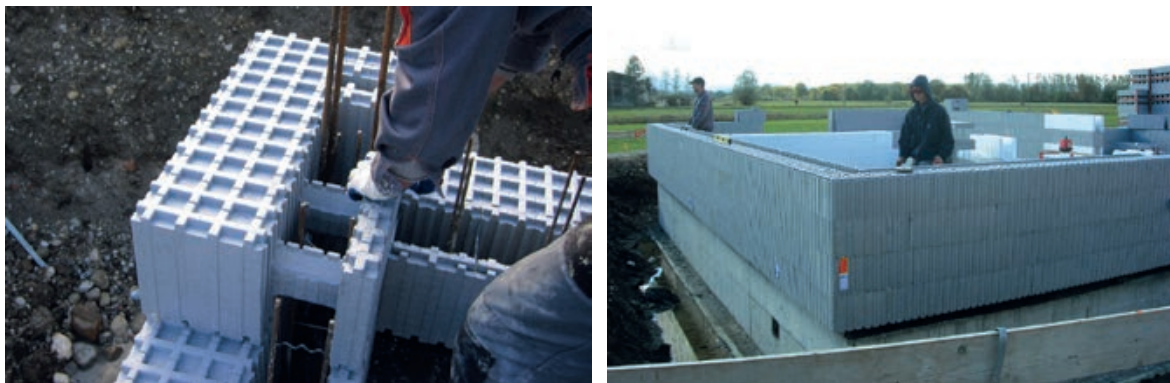
Slika 3-225 Zid ukupne debljine 43 cm građen ICF sustavom [200]
