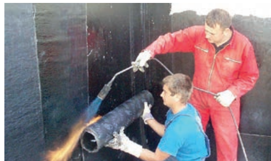
Slika 1-8 Izvedba hidroizolacije [8]
