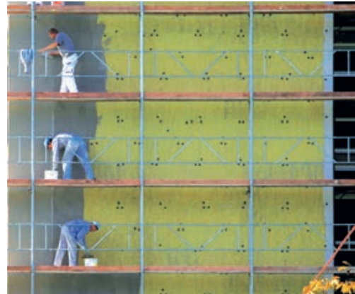
Slika 3-88 Postavljanje toplinsko-izolacijske ploče i lamele [9]
