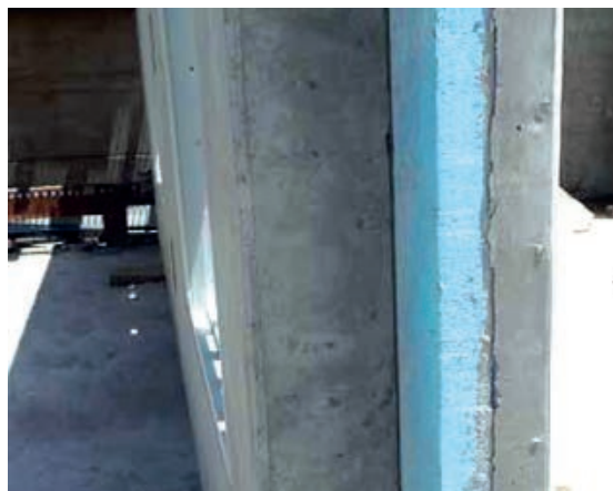
Slika 3-186 Presjek predgotovljenog zidnog panela tipa s EPS-om kao toplinskom izolacijom [56]
