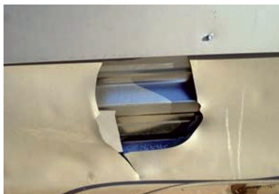
Slika 3-246 Oštećenje hidroizolacije zbog nedostatka UV stabilizatora [207]
