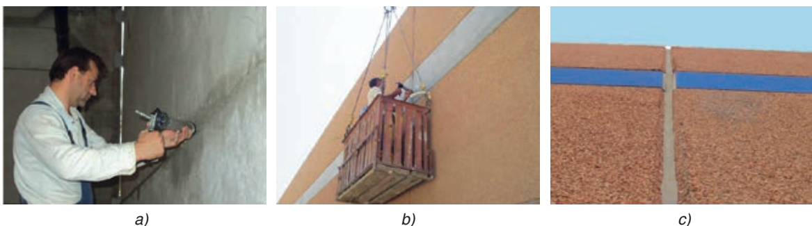
Slika 3-204 Brtvljenje sljubnica predgotovljenih betonskih panela s unutarnje strane a) , odnosno vanjske strane b) , obrađena sljubnica c) [184]
