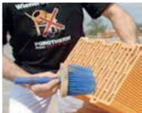
Slika 1-110 Čišćenje opeke [48]
