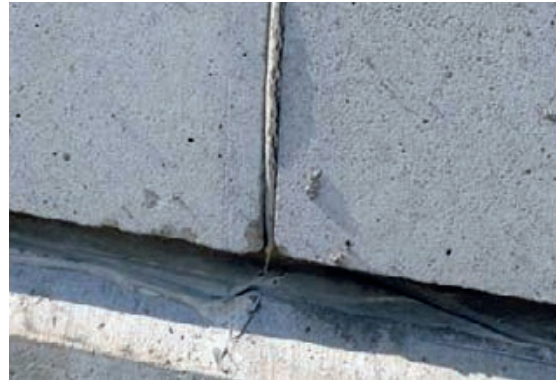
Slika 3-198 Primjer deformacije brtvila uslijed deformacije zidnih panela [185]
