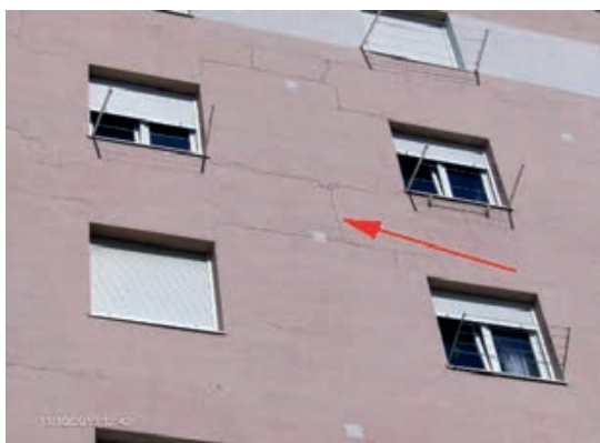
Slika 3-152 Neodgovarajuće ugrađen ETICS sustav
