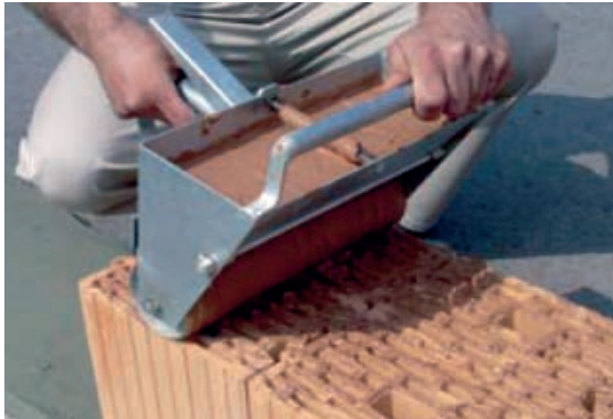
Slika 2-6 Nanošenje morta posebnim valjkom za zidanje [48]
