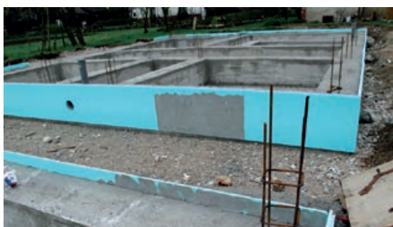
Slika 3-46 HI i TI trakastih temelja [104]
