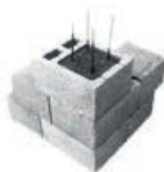
Slika 1-96 Blokovi za okomiti serklaž betonskih zidova
