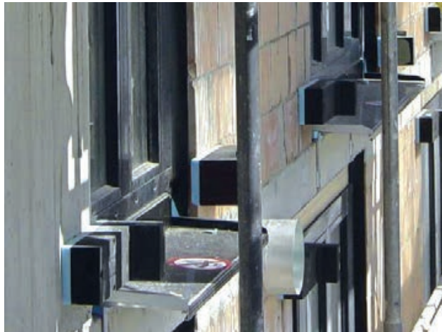
Slika 3-126 Pričvršćivanje dodatnih elemenata na ETICS sustav [136]
