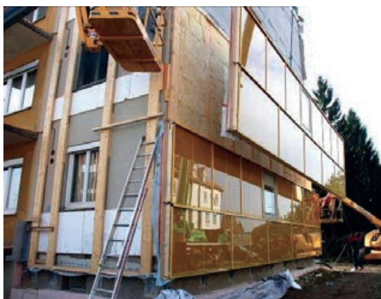
Slika 3-220 Ugradnja predgotovljenih panela [196]
