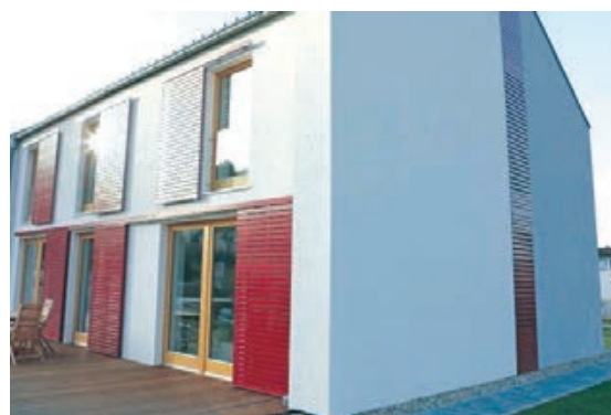
Slika 3-79 Podnožje u ravnini s pročeljem i istim završnim slojem [9]
