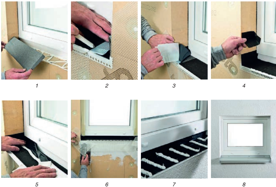
Slika 3-122 Proces ugradnje prozorske klupčice [9]
