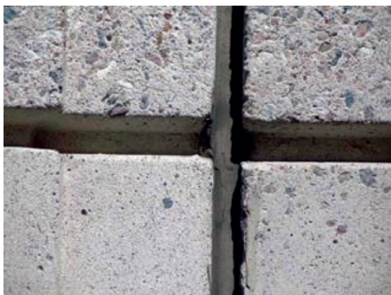
Slika 3-200 Predgotovljeni paneli su čisti, dok je brtvilo privuklo prljavštinu iz atmosfere [185]
