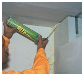
Tablica 1-11 Zidanje plinobetonom [76]
