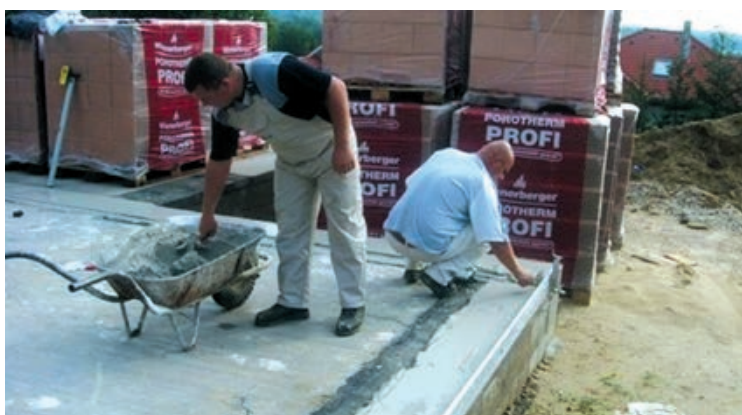
Slika 1-104 Izvedba HI temelja [48]
