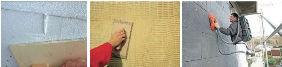
Slika 3-92 Brušenje EPS-a i mineralne vune [9], [119]
