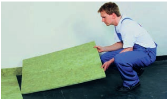
Slika 1-9 Izvedba plivajućih podova [9]
