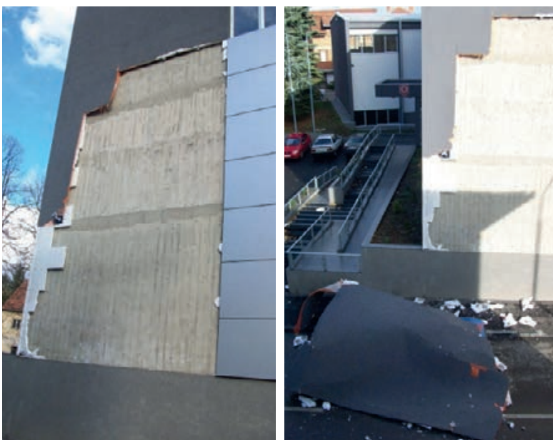
Slika 3-146 Neodgovarajuće ugrađen ETICS sustav, Poljoprivredni fakultet Vlasenica, BiH, studeni 2012. [9]
