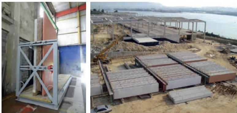
Slika 3-188 Skladištenje predgotovljenih betonskih elemenata u šoškama [56]
