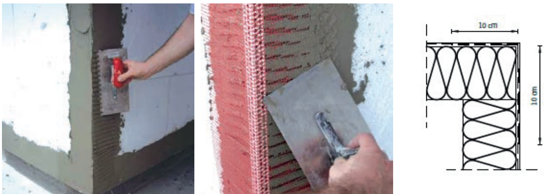
Slika 3-114 Izvedba ruba i kuta pomoću kutnog profila [9]
