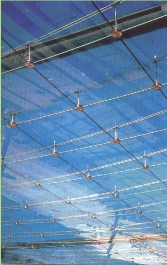
Ovješena staklena konstrukcija za Stadtbahn Heilbronn, Njemačka
