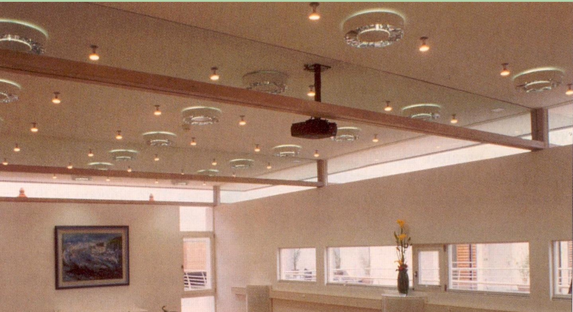
Spregnute grede drvo-staklo, Hotel Palafitte, Švicerska
