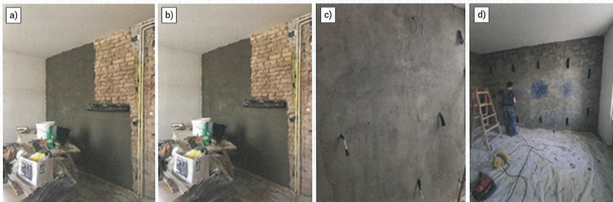
Slika G.37. Postupak ugradnje FRCM-a tijekom potresne obnove obiteljske kuće u gradu Zagrebu: a) ugradnja FRCM mreže; b) završni sloj morta; c) ugradnja užadi; d) impregnacija užadi
