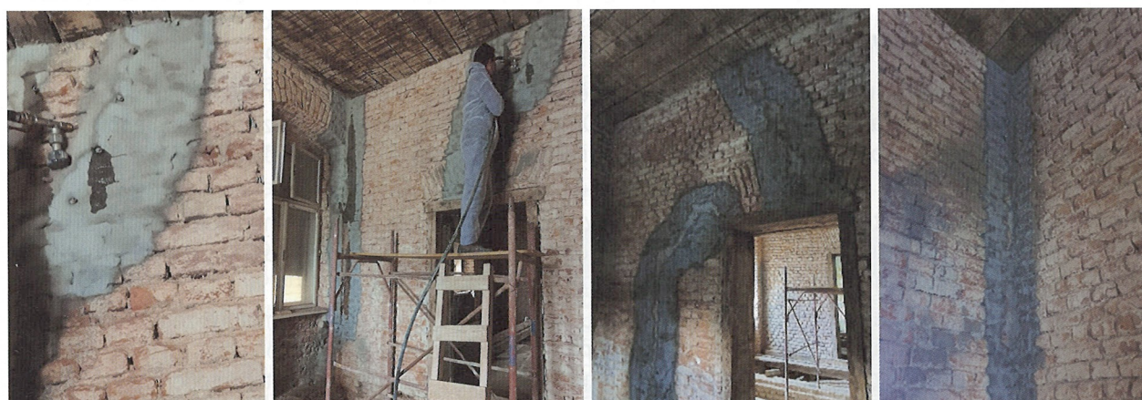
Slika G.18. Primjer injektiranja pukotina u zidanoj konstrukciji
