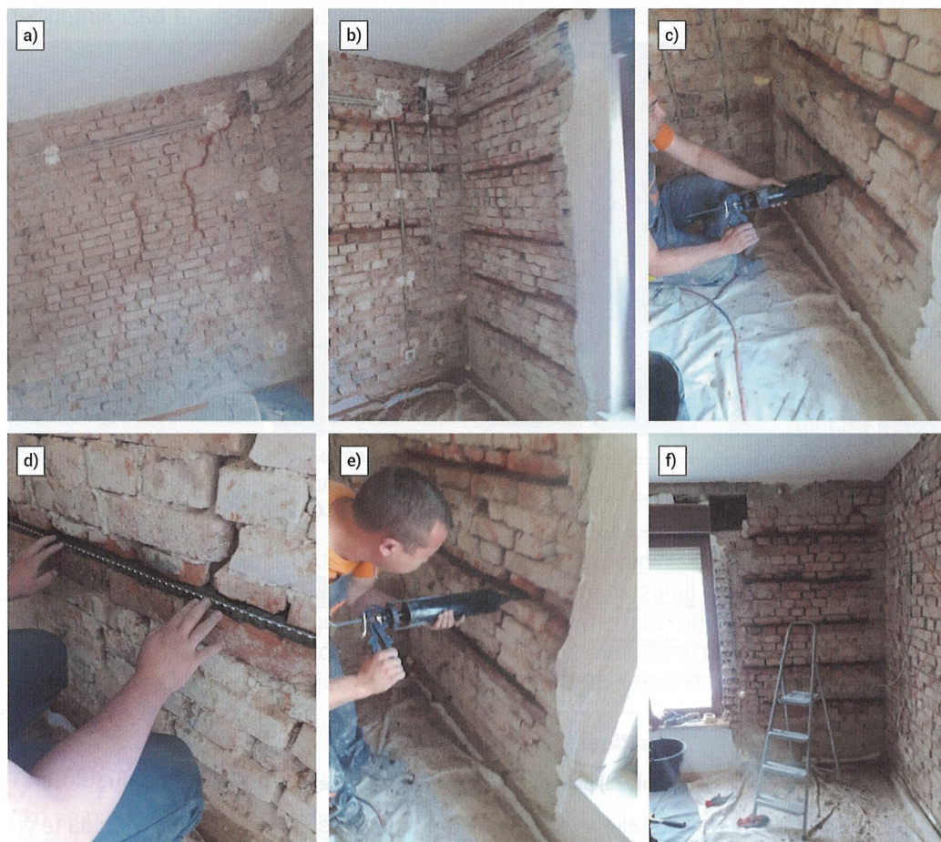
Slika G.15. Primjena spiralno oblikovanih sidara u sljubnicama: a) utvrđivanje smjera pukotine; b) uklanjanje morta iz sljubnica; c) izvođenje prvoga sloja morta; d) utiskivanje spiralno oblikovanoga sidra; e) izvođenje drugoga sloja morta; f) raspored armiranih sljubnica u zidu
