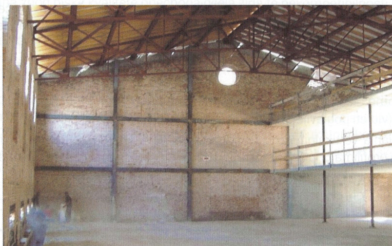
Slika G.27. Ukrućivanje zida izvan ravnine čeličnom konstrukcijom
