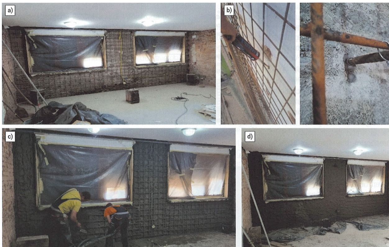
Slika G.32. Primjer pojačanja zidova torkretiranjem: a) postavljena armatura; b) sidrenje i povezivanje s Q mrežom; c) prvi sloj torkreta; d) drugi sloj torkreta
