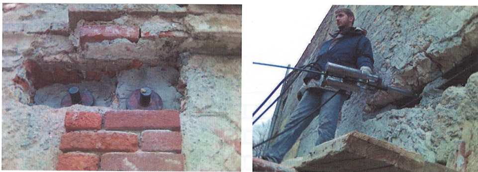
Slika G.23. Primjer izvedbe naknadno prednapetih zatega
