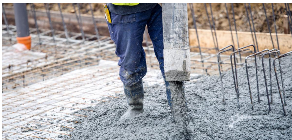
Slika 23: Lijevanje betona (Izvor: Port Aggregates Inc., 2020)*
