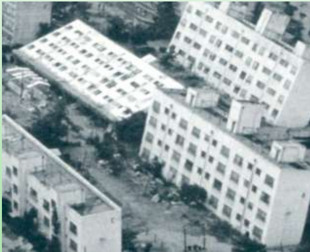
SLOM TEMELJNOG TLA
