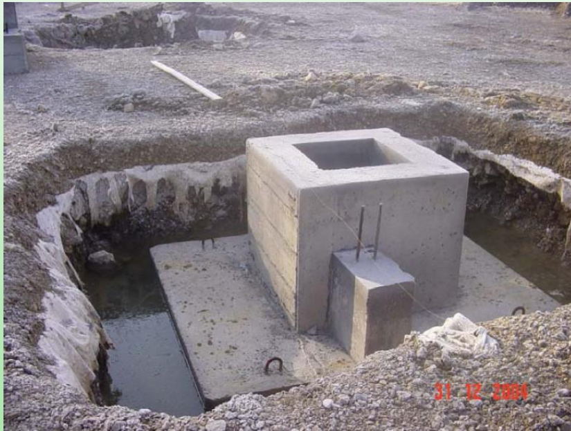
Slika 4-2 Temelj samac (lijevo) i temeljna traka (desno)
