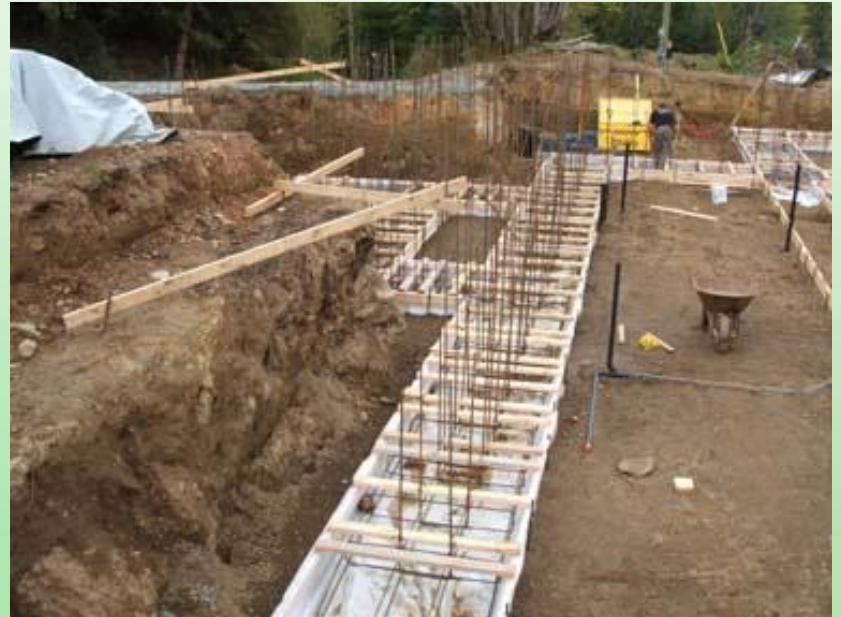
Slika 4-2 Temelj samac (lijevo) i temeljna traka (desno)
