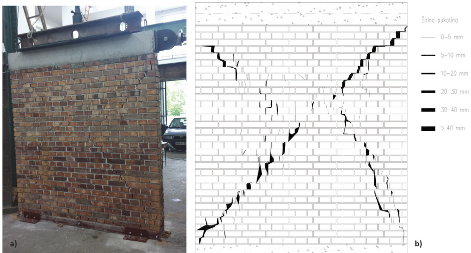
Slika 3. a) Zid W1 nakon ispitivanja, b) raspored i širina pukotina
