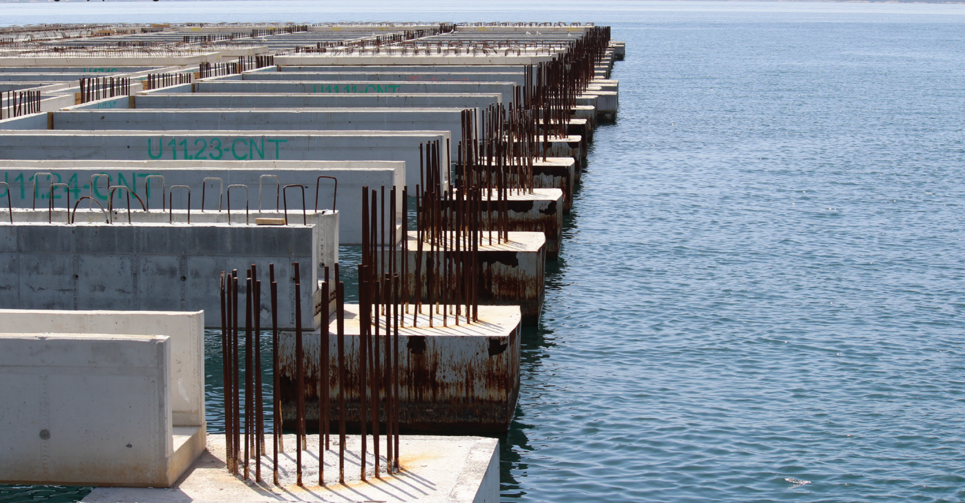
Izgradnja hidroelektrane Lešće na rijeci Dobri
