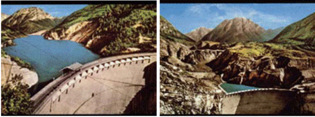
Slika 13-5. Klizanje tristo milijuna kubičnih metara stijene i tla u akumulacijsko jezero netom završene lučne brane Vajont u talijanskim Dolomitima (oko 100 km sjeverno od Venecije) prouzročilo je u listopadu 1963. godine vodni val visine preko 100 m, koji je nakon prelijevanja brane (koja je ostala gotovo neoštećena!) doslovce izbrisao nizvodni gradić Langaronne i usmrtio preko 2000 njegovih žitelja.
