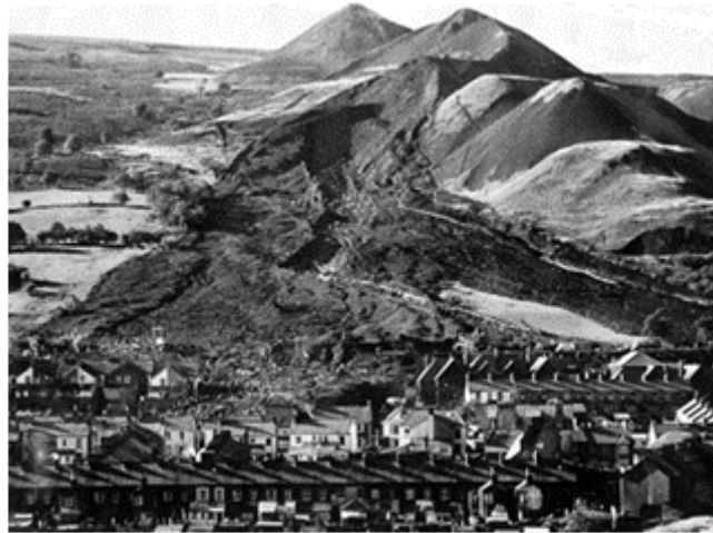
Slika 13-6. Veliko klizište na nasipu rudarske jalovine u Aberfanu (Velika Britanija) 1966. godine koje je usmrtilo nekoliko desetaka ljudi
