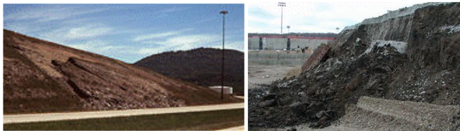
Slika 13-4. Klizanja tla na kosinama usjeka
